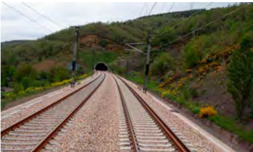
Doble vía en ancho ibérico (izda.) y tercer hilo (dcha.) en dirección a un túnel monotubo.
