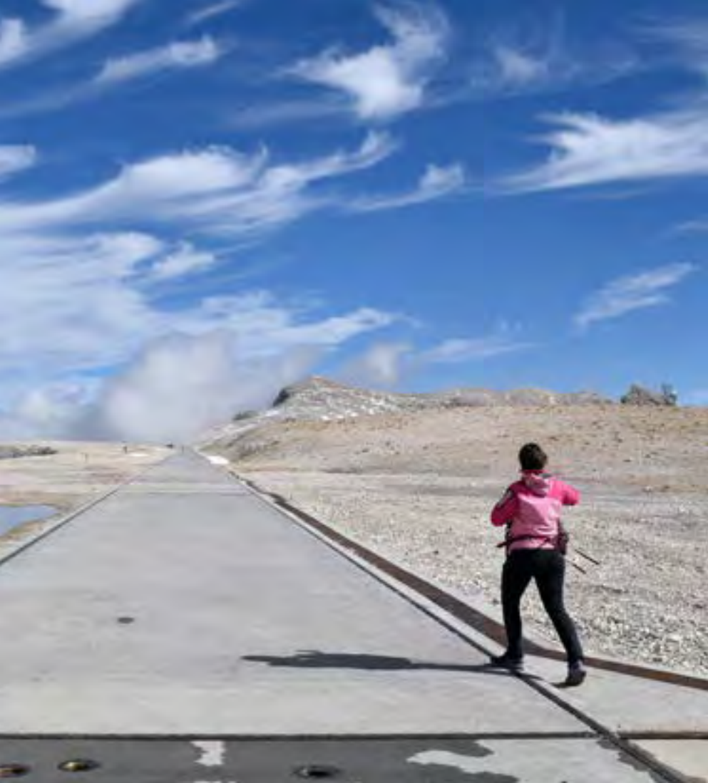
Los raíles sobre los que se mueven las antenas se extienden hasta 1,7 km | IRAM.
