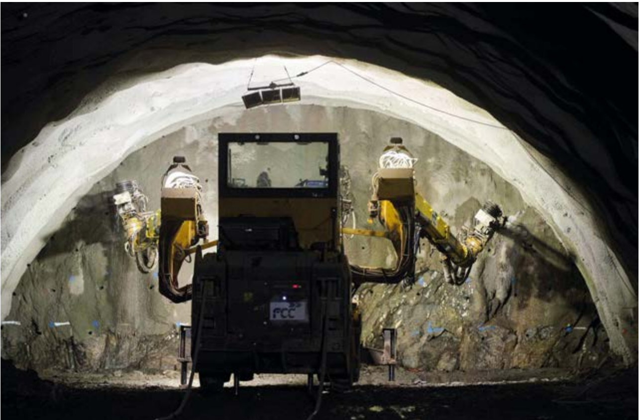
Uno de los jumbos ataca el frente de excavación.
