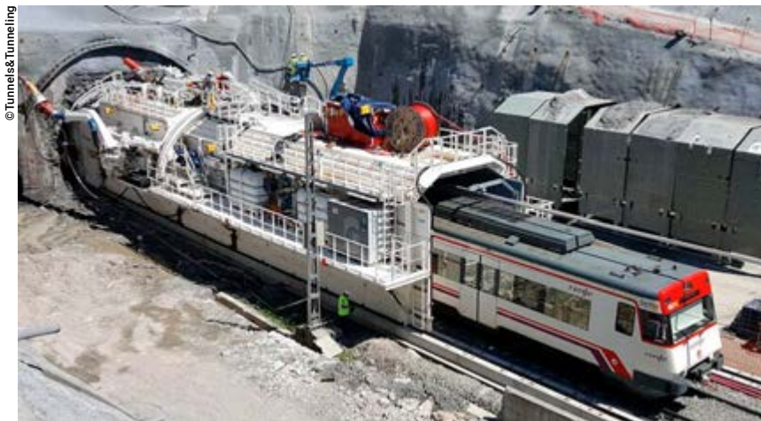
Ataque a la boca del túnel y circulación de un tren por el interior de la perforadora, en 2018.
