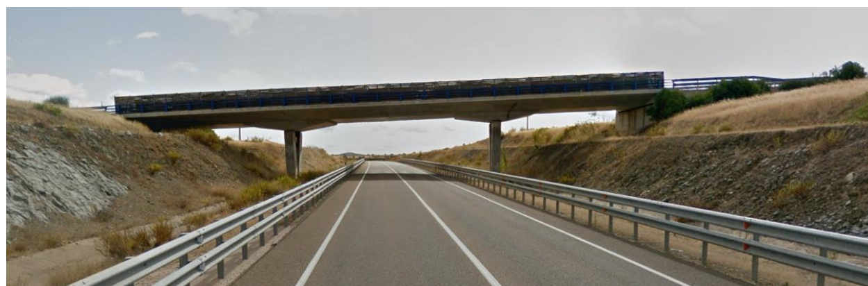
Figura 16. Paso superior existente en la variante de Santa Marta, en el emplazamiento del PS 039.4
