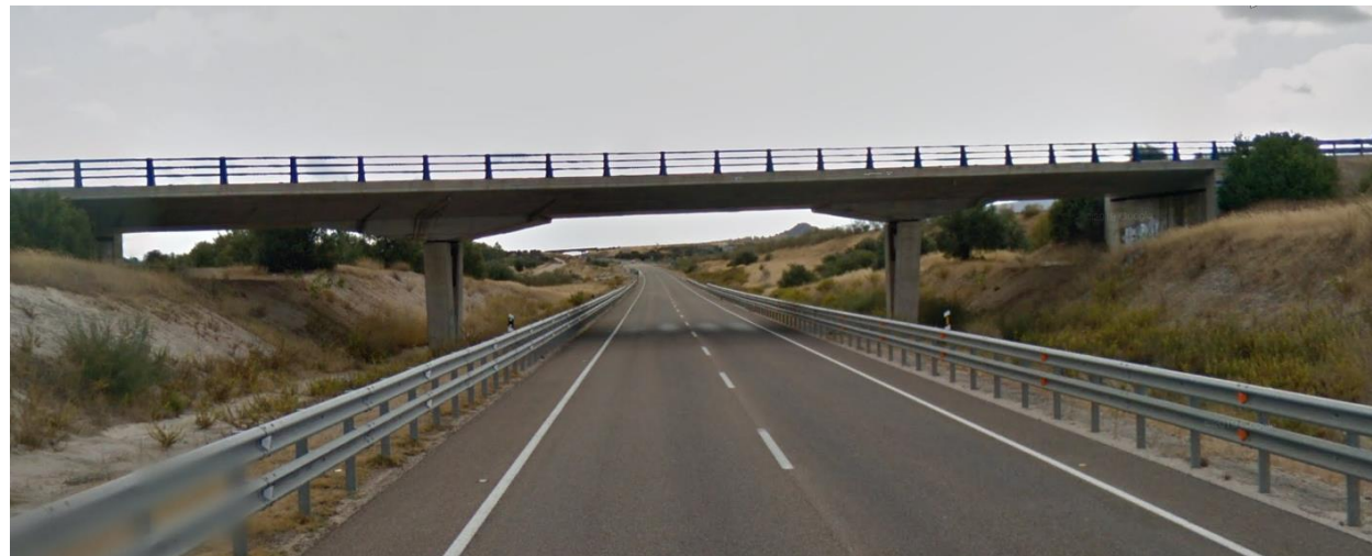
Figura 15. Paso superior existente en la variante de Santa Marta, en el emplazamiento del PS 038.0
