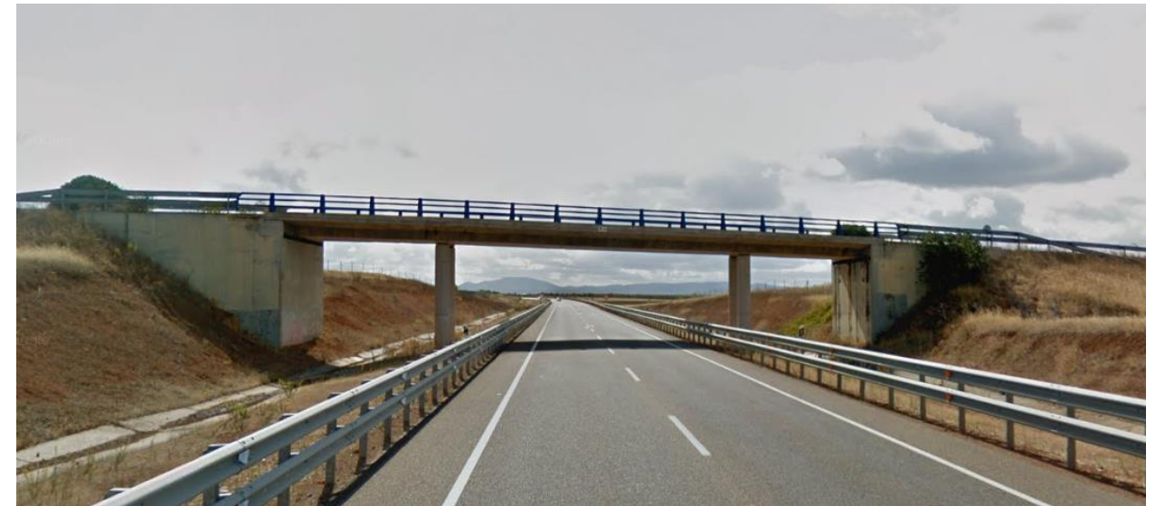
Figura 13. Paso superior existente en la variante de La Albuera, en el emplazamiento del PS 016.9
