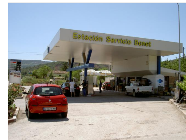
Figura 4.13 Estación de servicio Bonet. Aren, N-230, PK 102,0. Fuente: Elaboración propia.
