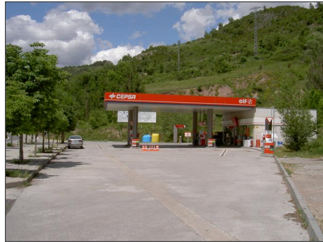
Figura 4.14 Estación de servicio Cepsa. El Pont de Suert, N-230, PK 122,7. Fuente: Elaboración propia.
