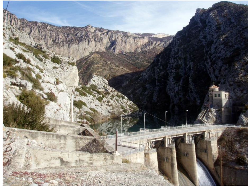
FOTOGRAFÍA 3. Presa del embalse de Sopeira.
