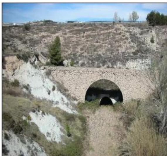
El arco del acueducto salva casi íntegramente la zona de flujo de agua, teniendo una sección superior a la de la obra de drenaje existente.
