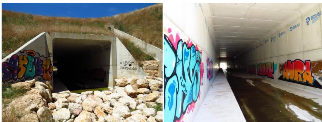
Incluso hay una acera dentro del cajón para facilitar el paso en seco cuando hay agua.
