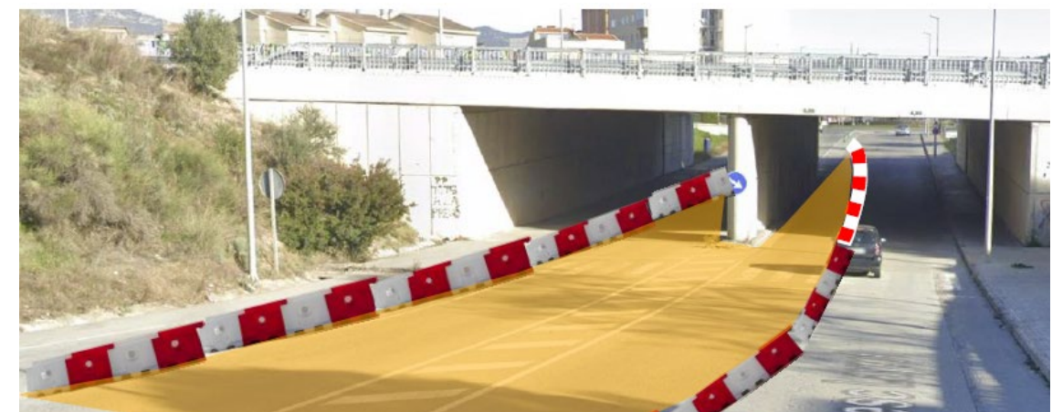
Fig. 104. Representación del corte por sentido del carril izquierdo para la ejecución de las obras de ampliación del paso inferior de Abrera.
