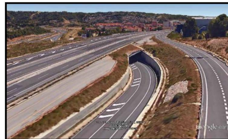
Ilustración 31: Detalle del sobrancho existente en el paso inferior
