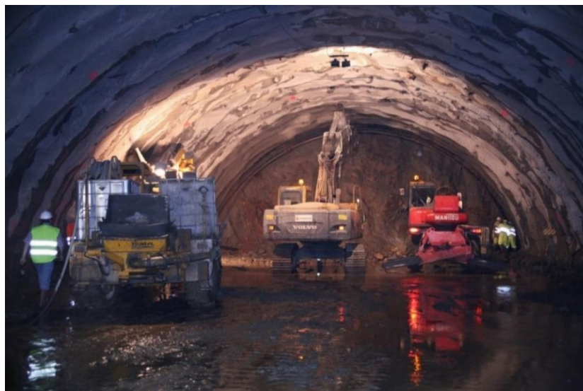
Construcción de la fase de Bóveda en un túnel siguiendo el SEM
