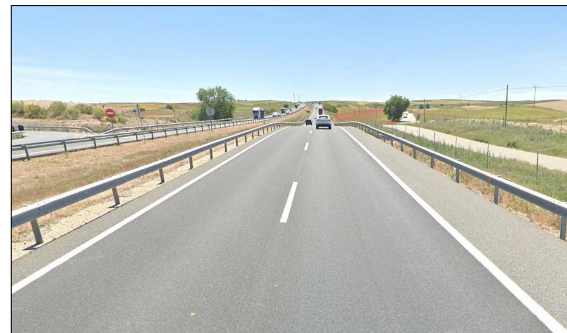
Vista de acuerdo Kv -1.500 m y +1.500 m posterior a mejorar en calzada derecha.
