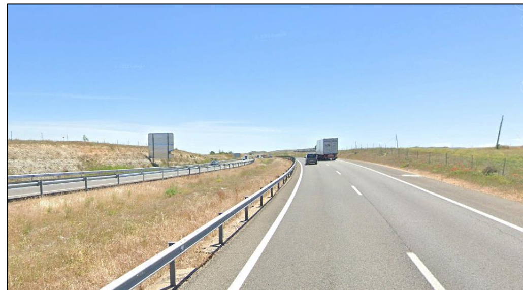
Vista de la zona de acuerdo convexo Kv -5.000 m, p.k. 69+450 eje 251, en calzada derecha.
