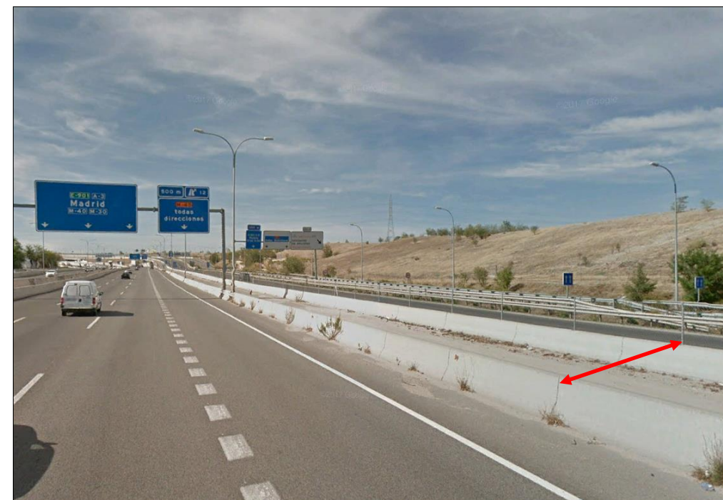
Vista de carril segregado en sentido Madrid.
