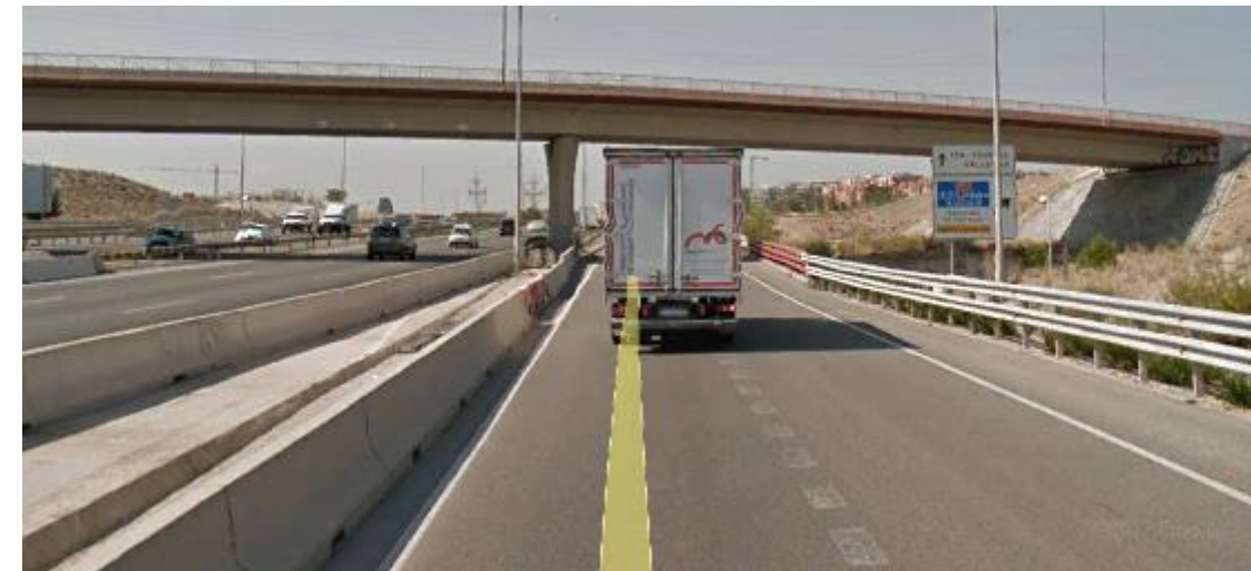
Punto de rectificación en planta de la calzada de la vía de servicio
