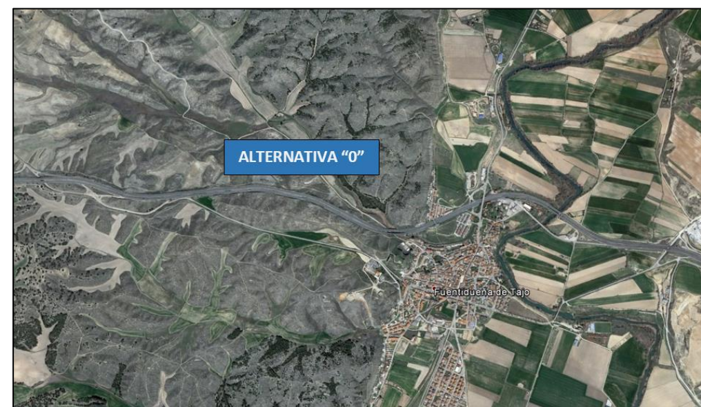
Vista en planta de la Alternativa "0" de la Variante de Fuentidueña de Tajo.
