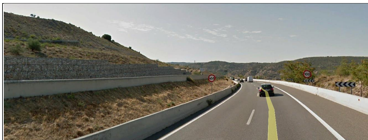
Vista, en sentido Valencia, de uno de los tramos con calzadas a distinto nivel y muro de gaviones en calzada izquierda.
