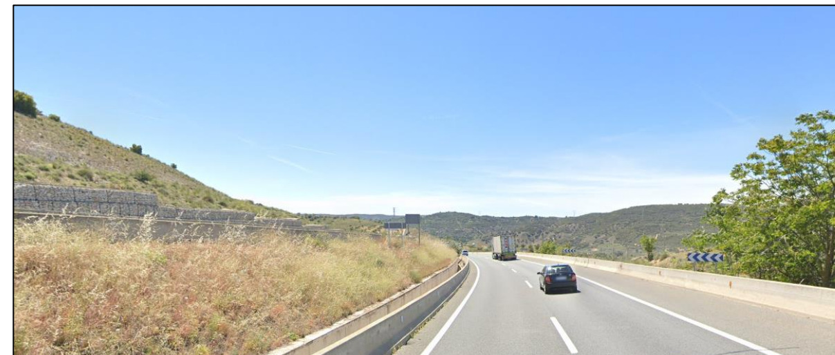
Imagen obtenida de "Google Maps". Se puede observar la diferencia de cota entre calzadas, así como la reducida visibilidad de parada en la curva a izquierdas de la calzada baja en este punto.
