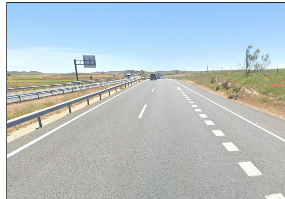
Vista de la zona de acuerdo convexo Kv -2.000 m, p.k. 68+685 eje 251, en calzada derecha.
