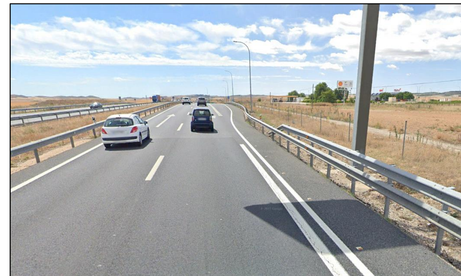
Vista de la zona de acuerdo convexo Kv -5.000 m, p.k. 67+942 eje 251, en calzada derecha.
