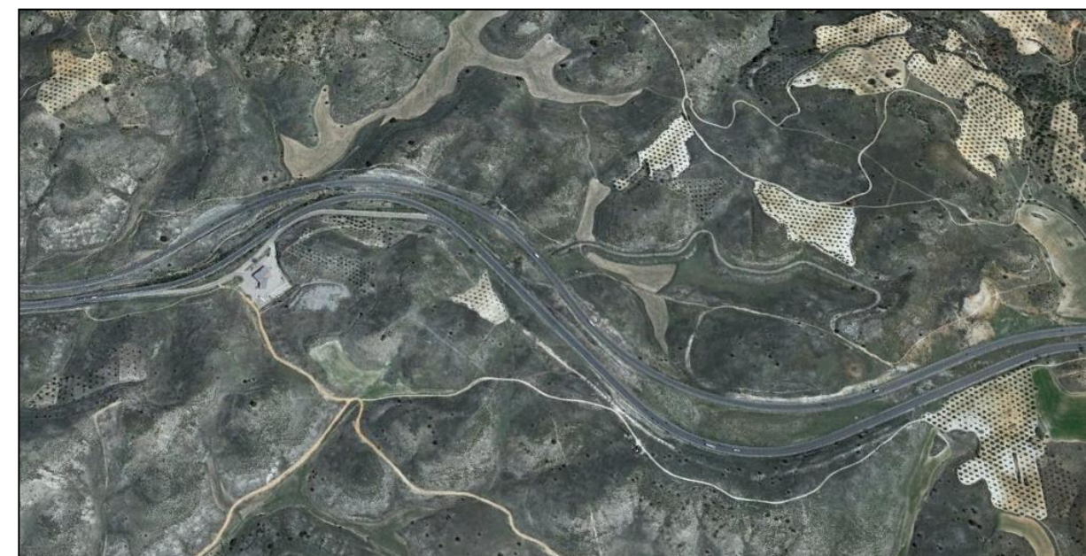
Tramo actual de la A-3 que se modificará con la rectificación de trazado entre los pp.kk 41 y 46.
