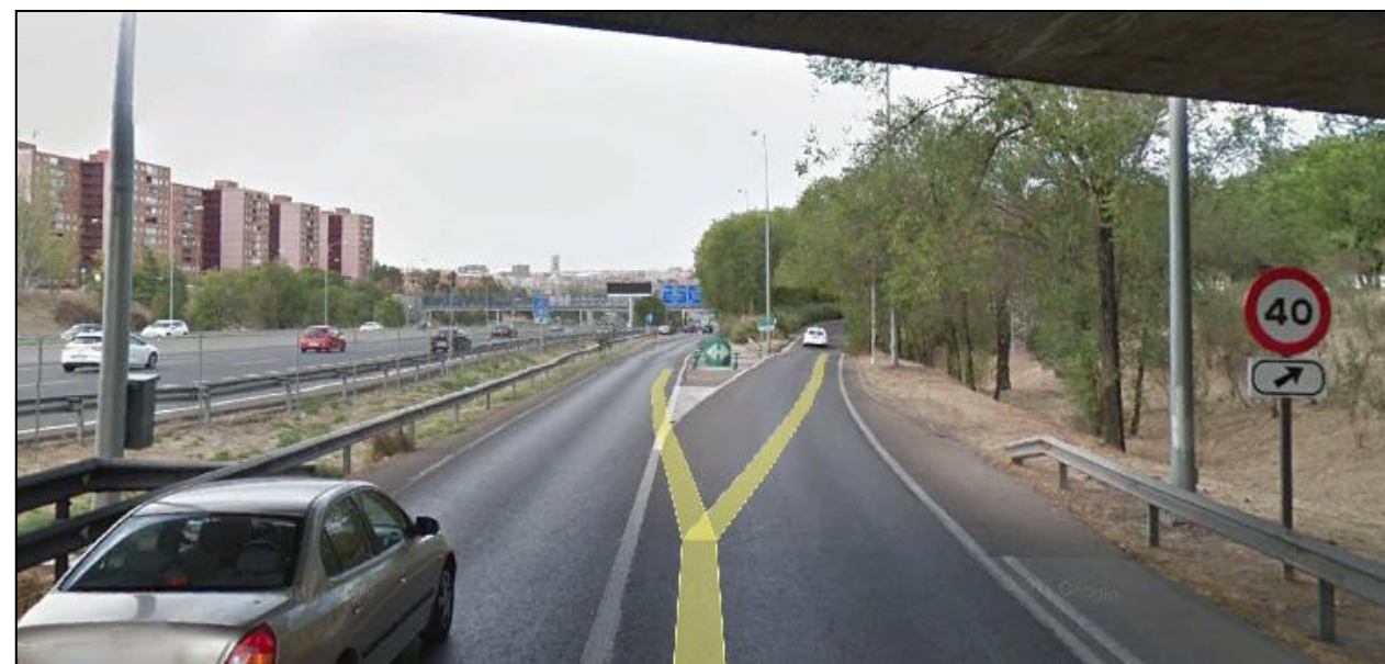
Vía de servicio izquierda a la altura del inicio del ramal de transferencia tronco-vía lateral que cruzará bajo la vía.
