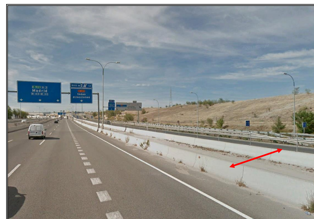
Vista de carril segregado en sentido Madrid
