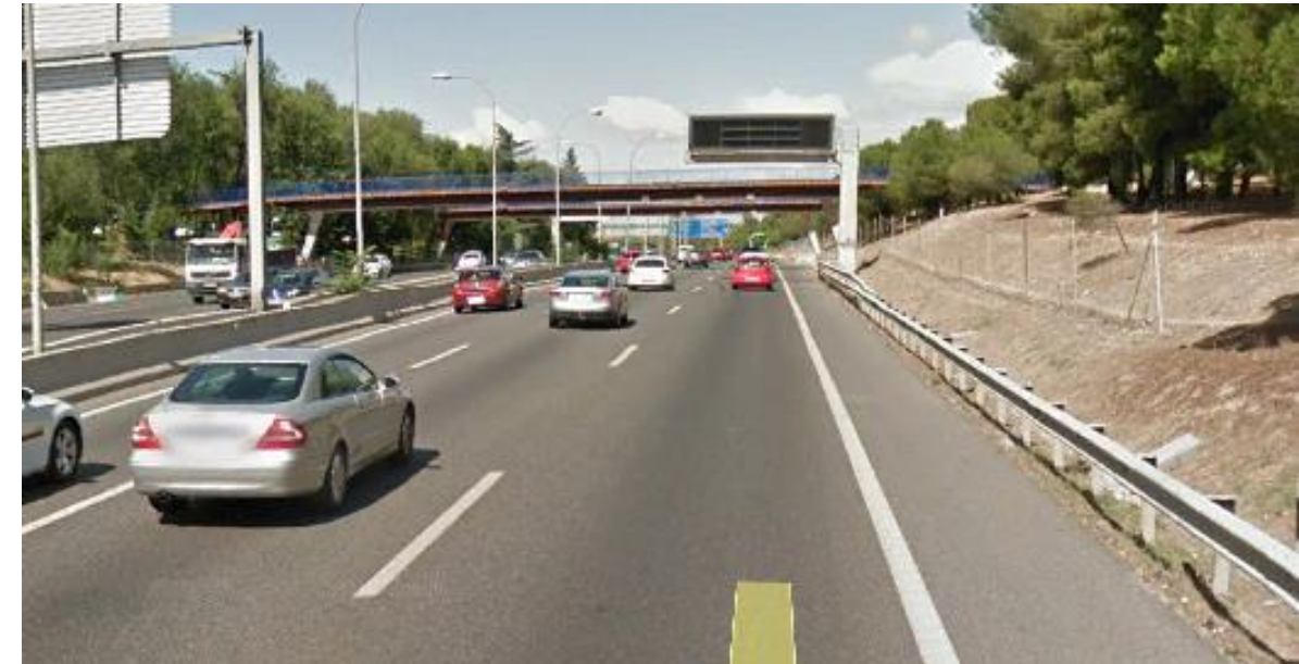
Zona de incorporación de carril por el exterior que funcionará como carril especializado para Tte Público
