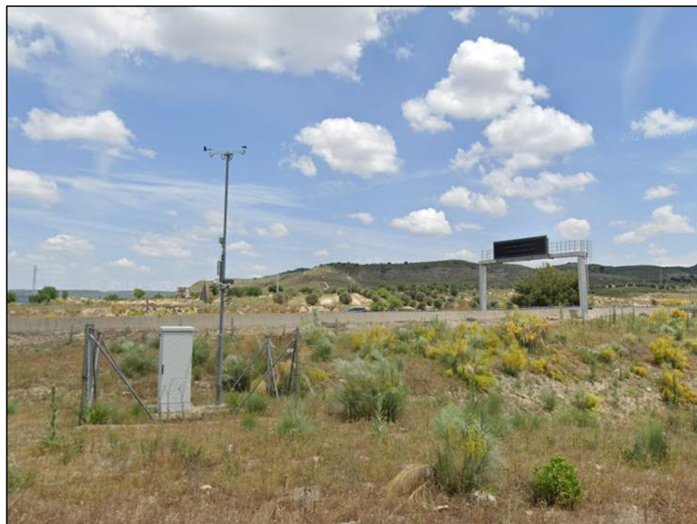
Estación meteorológica a la altura del P.K. 40+850 de la calzada sentido Valencia.
