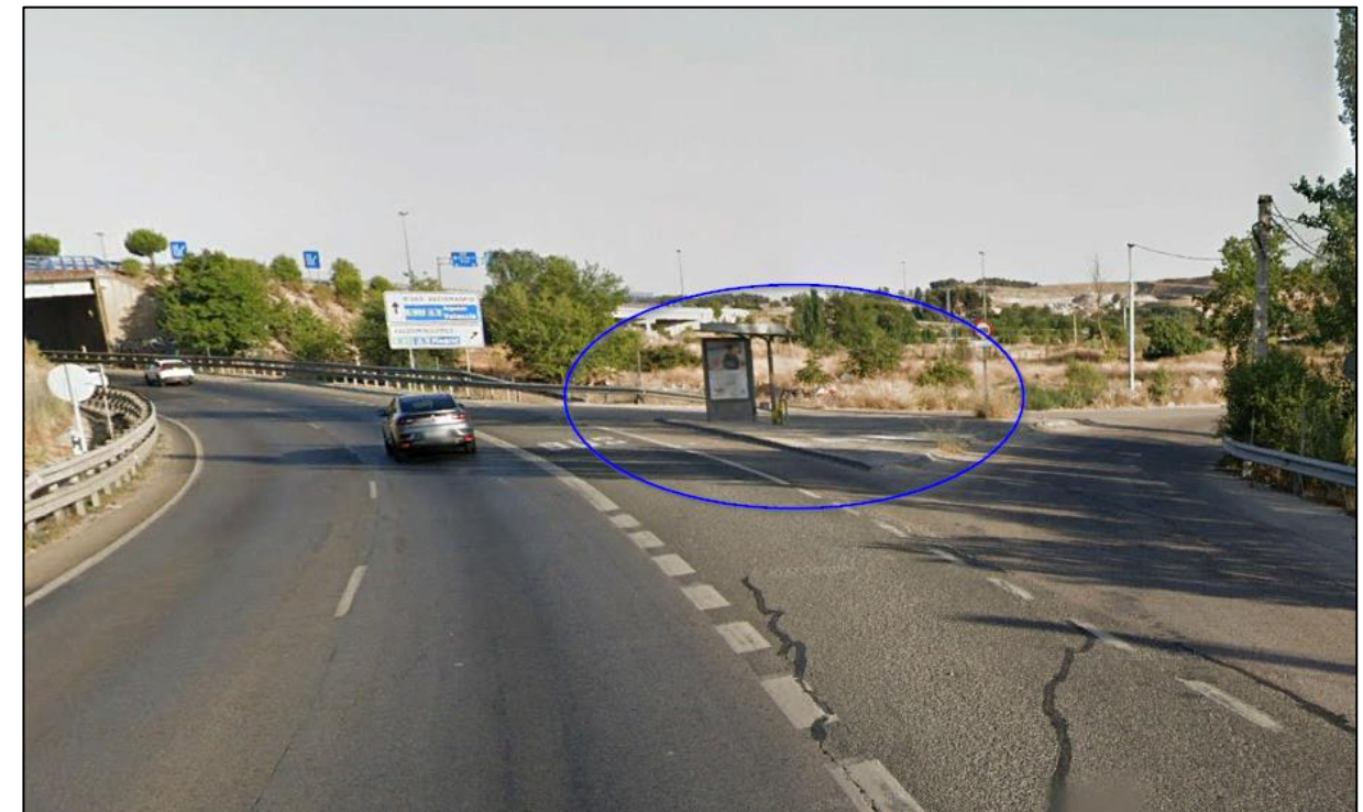
Imagen tomada del Google Street View. Parada de autobuses 13 situada en P.K. 13+300 MD
