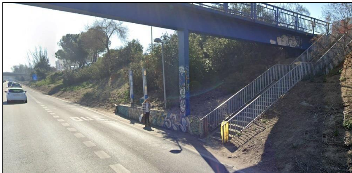
Imagen tomada Google Street View. Peatón esperando en parada autobuses 02 situada en P.K. 4+900 MD
