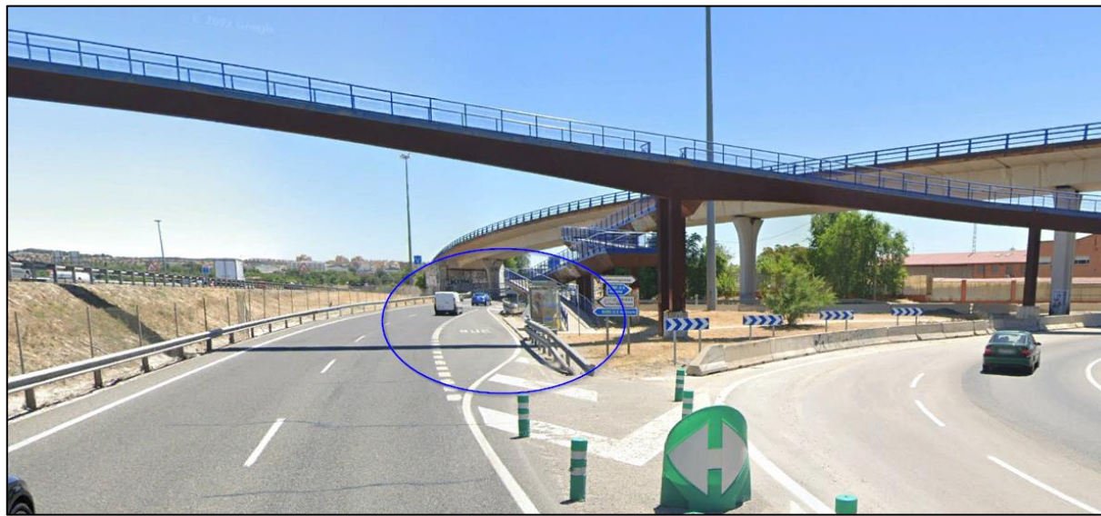
Imagen tomada del Google Street View. Parada de autobuses 15 en vía de servicio P.K. 14+000 MD
