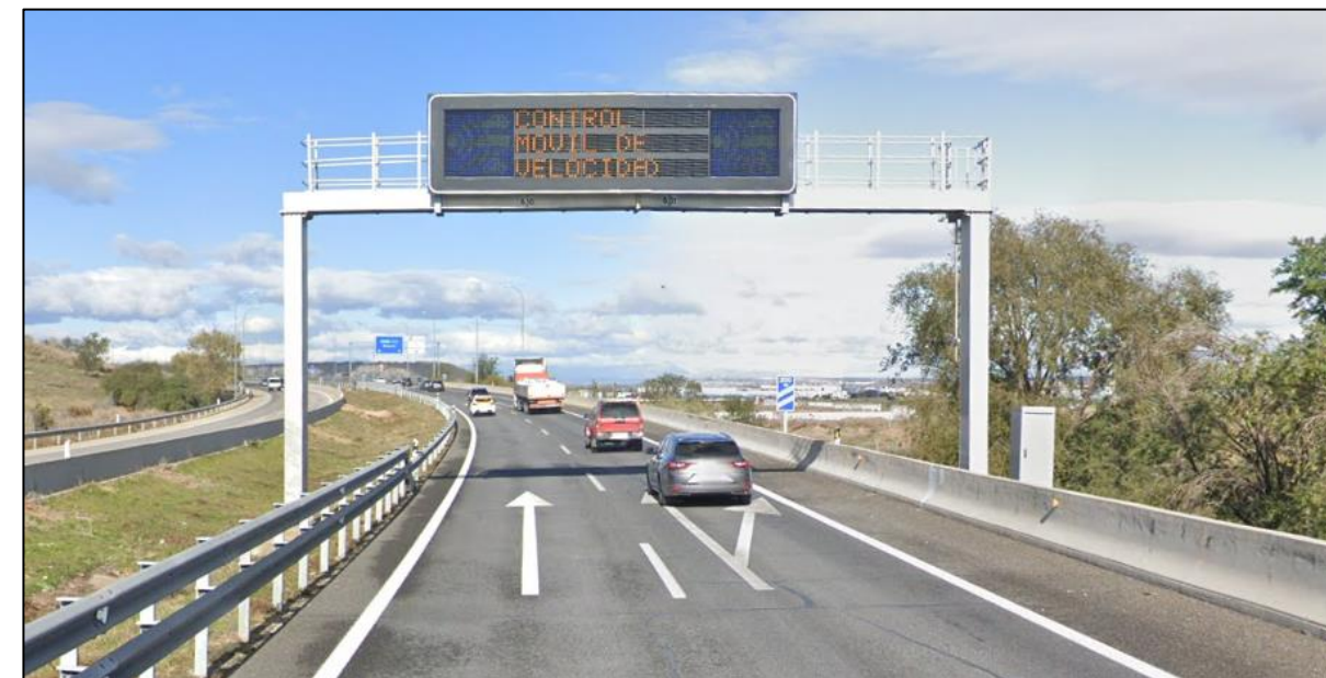
Pórtico de señalización variable a la altura del P.K. 26+200 de la calzada sentido Madrid.
