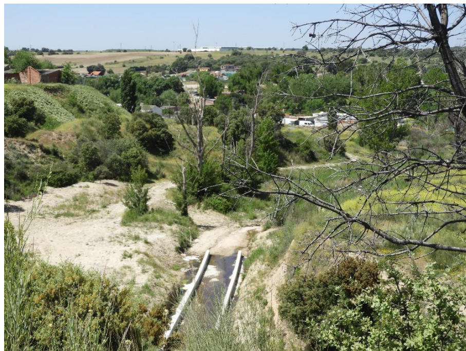
Punto 23. P.K. 16+450 margen izq
