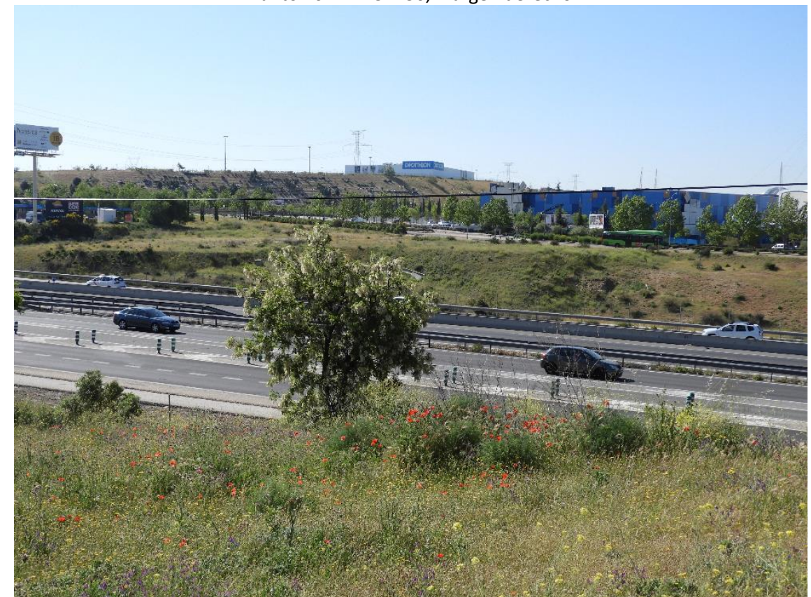
Punto 20. P.k 15+250, margen derecho
