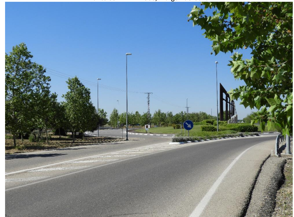
Punto 35. P.K. 21+500, margen derecho
