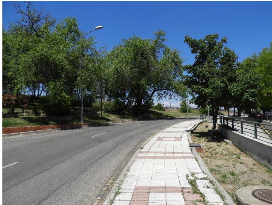
Punto 4. P.K. 3+550 margen izq
