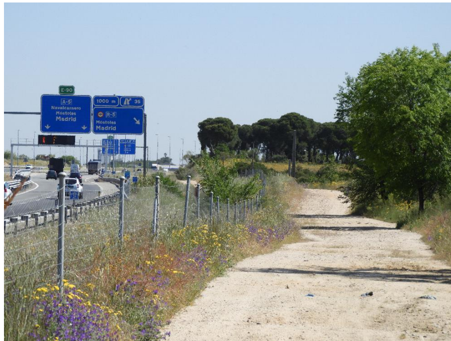
Punto 40. P.K. 27+500 margen izq
