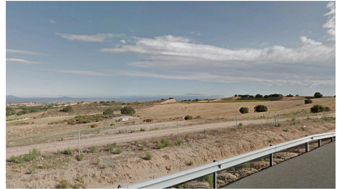
Punto 48. P.K. 46+000 margen dcho
