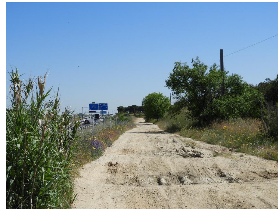
Punto 40. P.K. 27+500 margen izq
