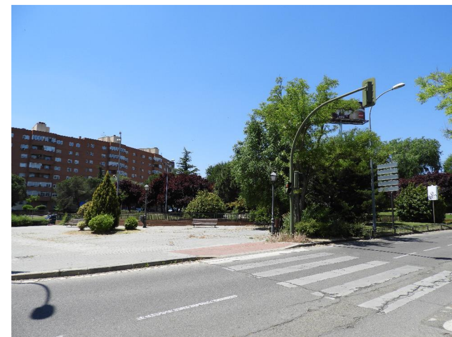
Punto 4. P.K. 3+550 margen izq
