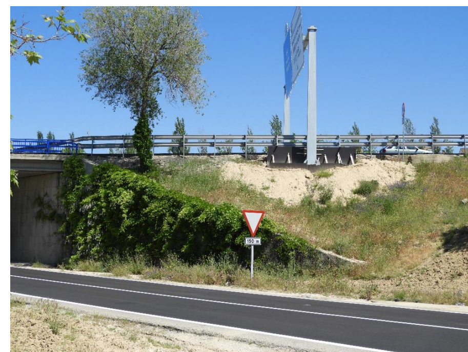
Punto 31b. P.K. 21+500 margen izq
