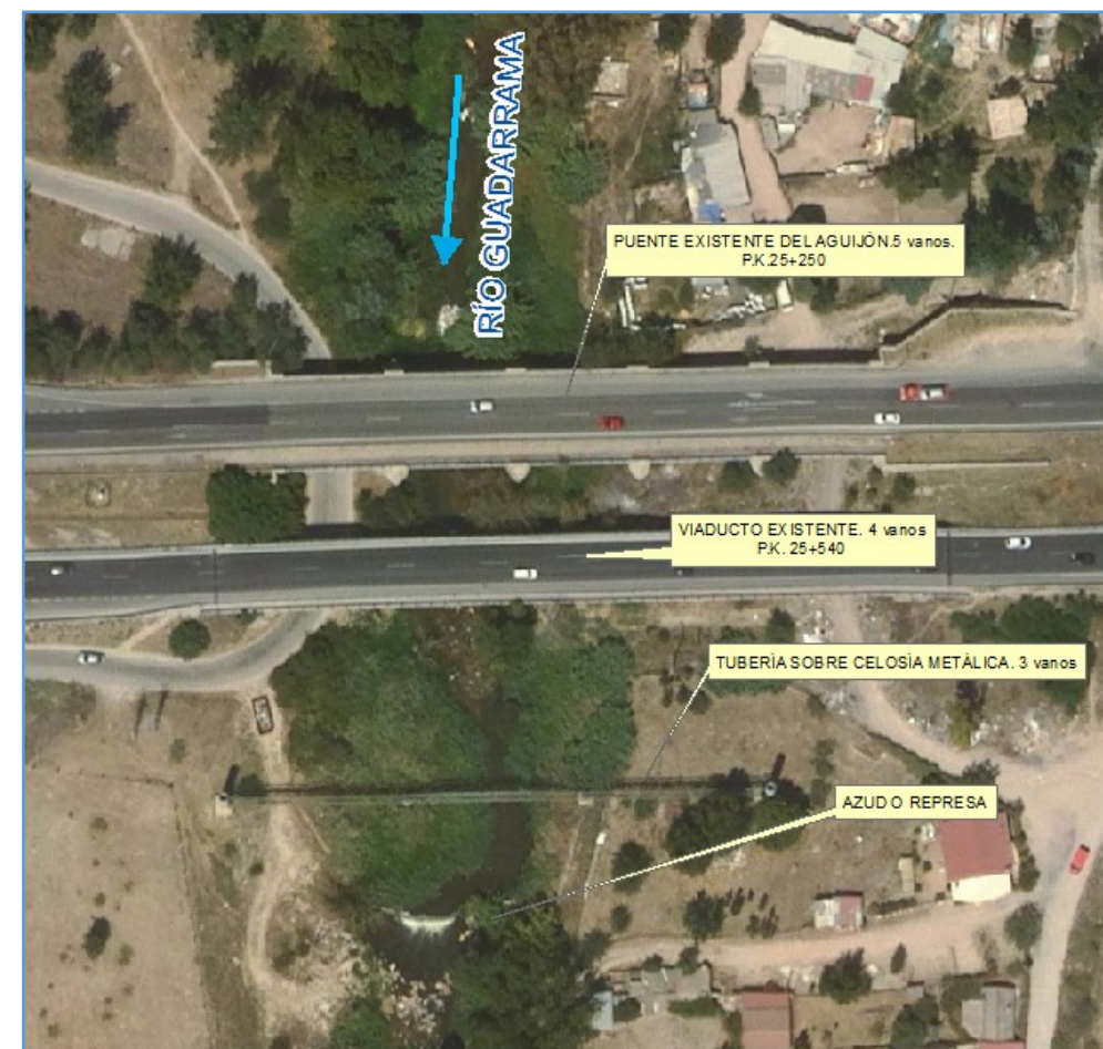
Imagen 3.1 Viaducto Guadarrama. Situación actual.
