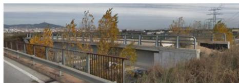
Esta estructura, que sirve de paso para un vial de salida de la zona comercial sobre la carretera C-31c, se encuentra totalmente ejecutado a falta de la losa de transición de su estribo sur.
