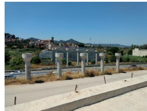
Ambos estribos y dos de las tres filas de pilas están completamente ejecutados. Quedarían por ejecutar las pilas centrales, el trasdosado y losa de transición del estribo oeste y el tablero completo.
