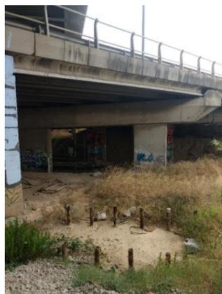
Esta actuación consiste en un ensanche de la estructura existente sobre una vía doble de "Ferrocarrils de la Generalitat Catalana" (FGC en adelante). Actualmente se encuentran ejecutados los micropilotes de la cimentación de los estribos, a ambos lados de la carretera C-245, tal como se proyectaba anteriormente. Ahora solo se proyecta el ensanche por la margen oeste, por lo que únicamente serán aprovechables los micropilotes de ese lado, restando por ejecutar el resto de la estructura.
