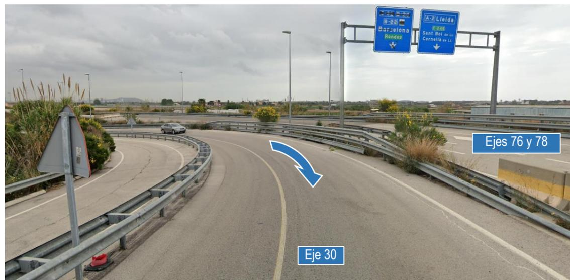
Teniendo en cuenta los criterios actuales de la “Orden Circular 35/2014 sobre criterios de aplicación de sistemas de contención de vehículos”, se hace necesaria la sustitución de algunos sistemas de contención preexistentes o la adaptación de los proyectados anteriormente en diversos tramos de viales en tierras y, especialmente, en las siguientes estructuras:
