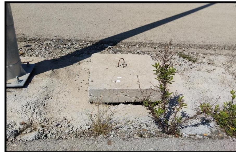
Foto 2. Arqueta de hormigón en mediana Eje 1.
