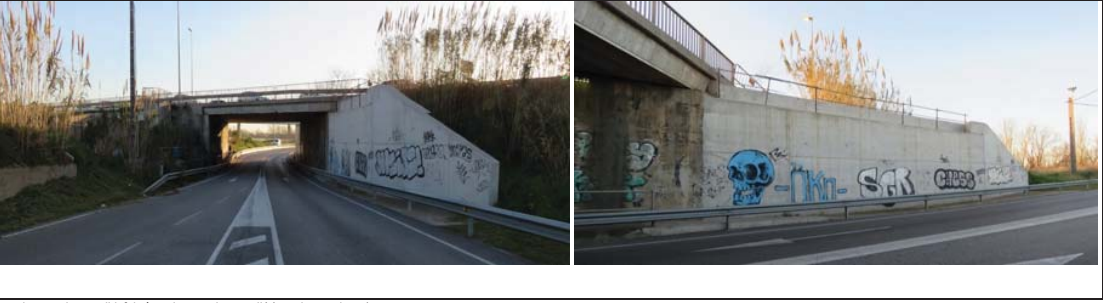
Estribo 1: Lado Castelldefels / Estribo 2: Lado Cornellà (acorde con planos)
