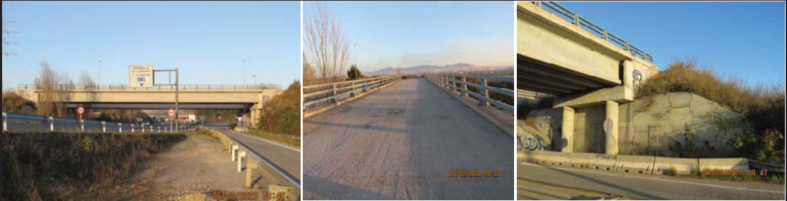
Estribo 1: Lado Suroeste / Estribo 2: Lado Noreste (acorde con planos)
