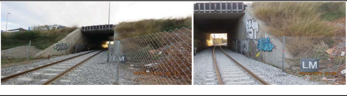
Estribo 1: Lado Castelldefels / Estribo 2: Lado Cornellá (acorde con planos)
