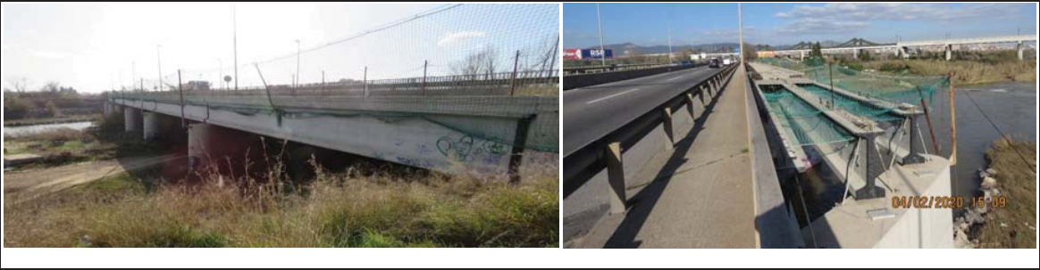
Estribo 1: Lado Castelldefels / Estribo 2: Lado Cornellà (acorde con planos)
