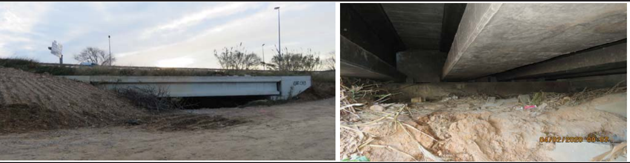
Estribo 1: Lado Cornellà /Estribo 2: Lado Castelldefells (acorde con planos)
