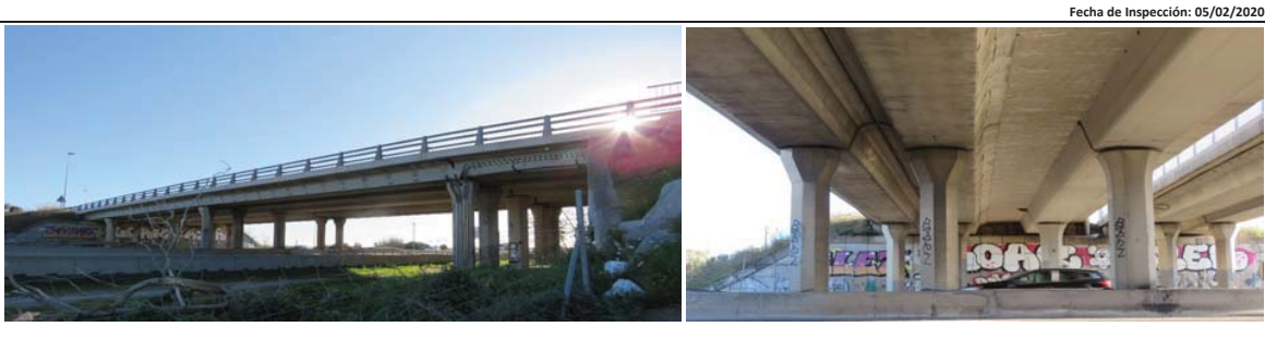
Estribo 1: Lado Noreste / Estribo 2: Lado Sureste (acorde con los planos)
