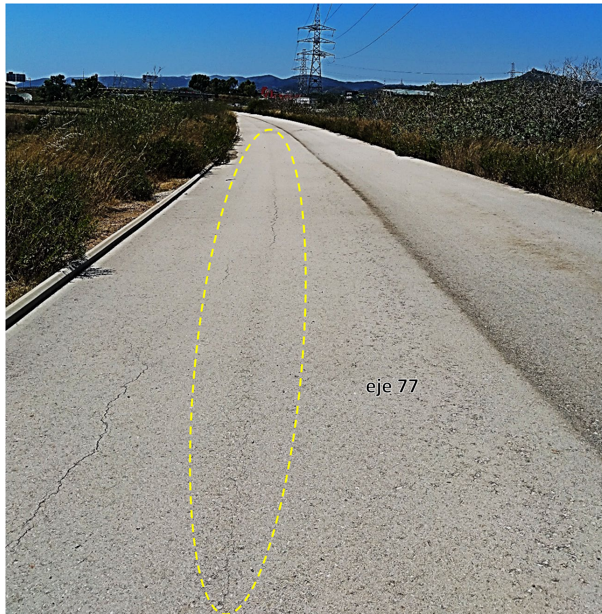
Vial de conexión C-32 / C-31c, sentido Castelldefels - El Prat (eje 77)
