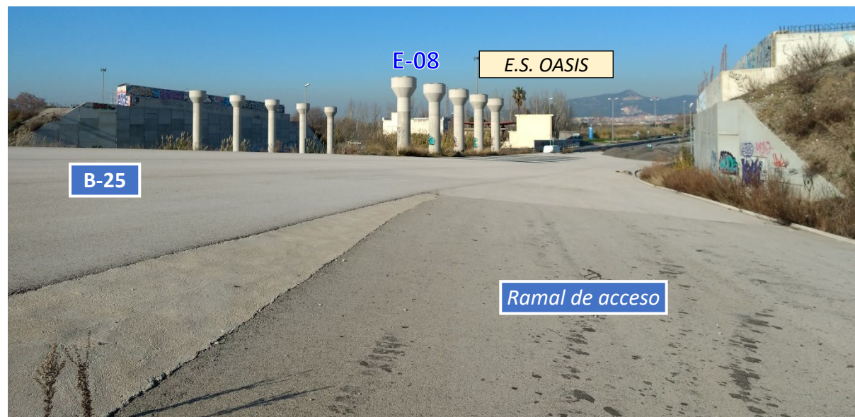
Carretera B-25 al sur de la estructura E-08
