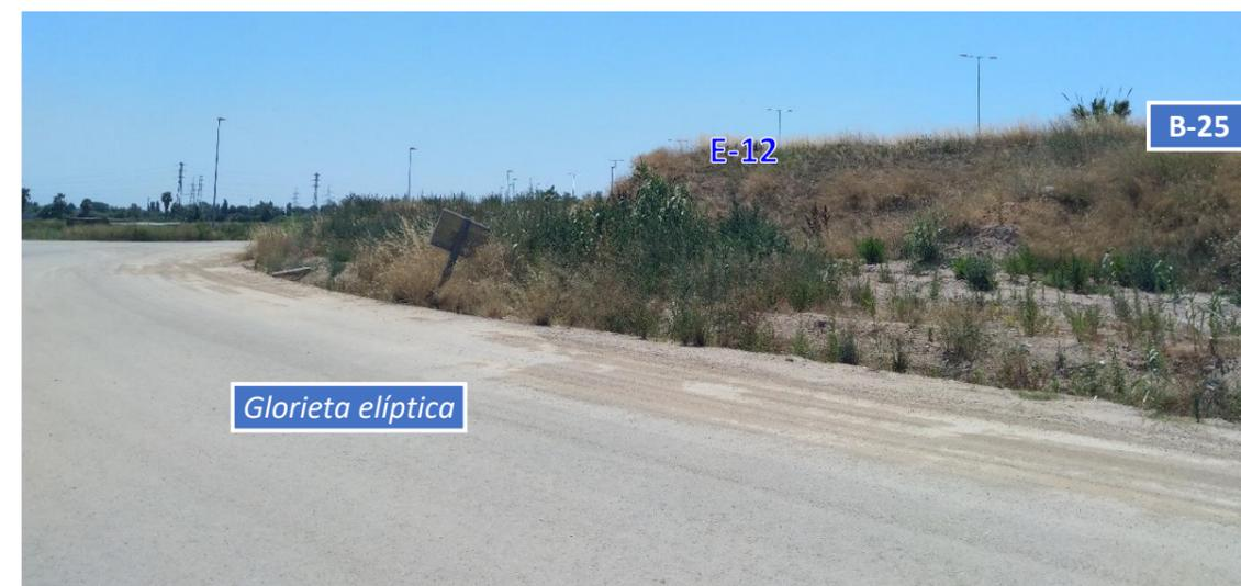
En la anterior imagen, orientada hacia el sur, se puede apreciar el estado actual glorieta elíptica (sin servicio) en el enlace de la carretera B-25 de Sant Boi – Cornellá. Como se puede ver, la calzada anular se encuentra pavimentada a falta de la capa de rodadura, y los rellenos de la carretera B-25 completamente ejecutados, a falta de desbrozar y regularizar los espacios internos, así como reperfilar los taludes.
