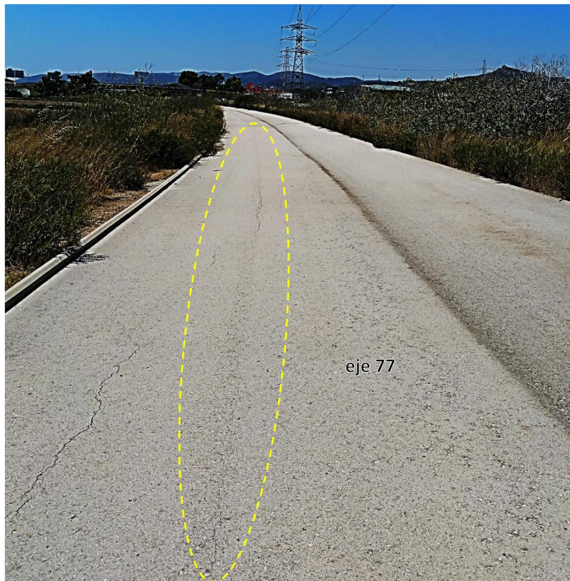
Este vial, que quedó ejecutado a falta de la capa de rodadura, equipamiento vial y alguna obra complementaria, presenta una grieta longitudinal de forma generalizada, motivada probablemente por la discontinuidad entre la sección de firme de la calzada y la del arcén derecho (a 2,50 m del borde), tal como se puede intuir en la anterior imagen. Se considera necesario instalar un elemento de refuerzo tipo geomalla para evitar el remonte de la grieta hacia la capa de rodadura.
