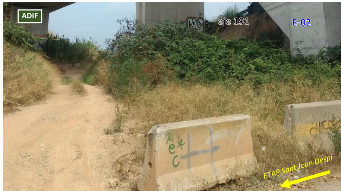
Por otra parte, en la siguiente imagen se puede apreciar el estado actual del camino que discurre en paralelo y al sur de las carreteras C-32 y C-31c para dar servicio al parque agrario. Los episodios de lluvias torrenciales ocurridos desde la paralización total de las obras han erosionado notablemente su sección. Se hace necesario, por tanto, reperfilar su cuneta y regularizar su firme.
