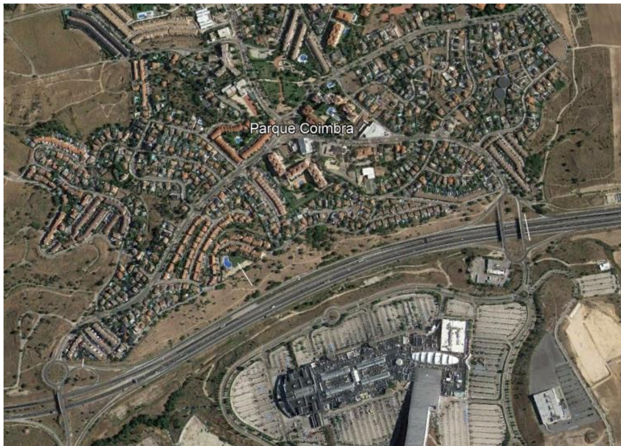
La actuación A10 A5_36,85_D se ubica en el margen derecho de la A-5, sentido Badajoz, entre la autovía A-5 y el camino situado junto a la zona verde de la "urbanización Calypo".
