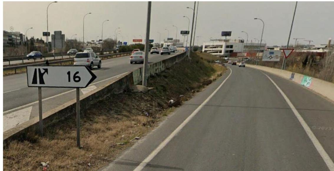
Fotografía 31. Final de la pantalla PT-11. Necesidad de protección en el vial inferior
