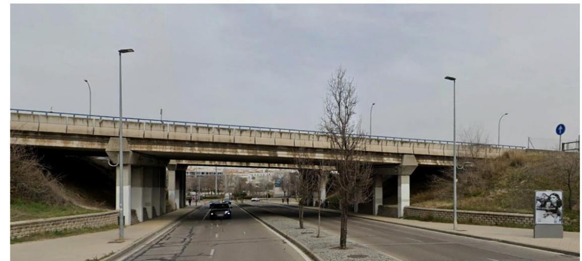
Fotografía 34. Sistemas de contención existentes en el recorrido de PT-13. Barrera de hormigón y pretil mixto
