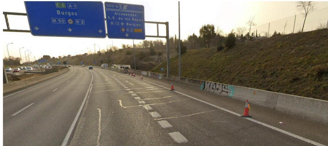
Fotografía 35. Pantalla PT-13. Ubicación frecuente alejada de calzada sobre cabeza de desmonte
