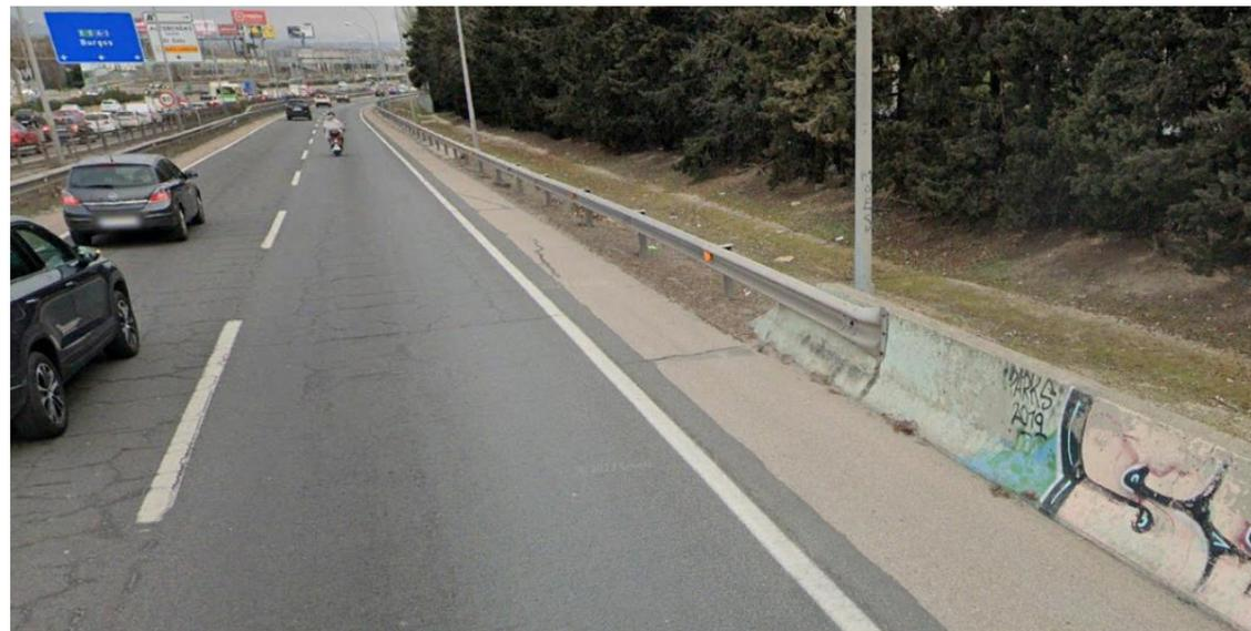
Fotografía 15. Pantalla PT-5 (PP\_A1\_14,25\_MD\_1\_4). Barrera metálica existente a continuación del pretil
