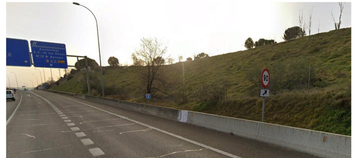
Fotografía 39. Sistemas de contención en PT-16. Barrera de hormigón en tronco. Barrera metálica en el ramal
