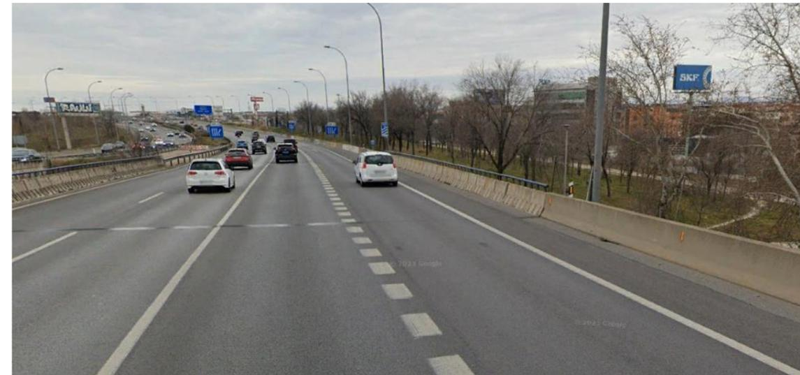
Fotografía 36. Tipología de sistemas de contención existentes en el recorrido de PT-14. Barrera de hormigón y pretil mixto
