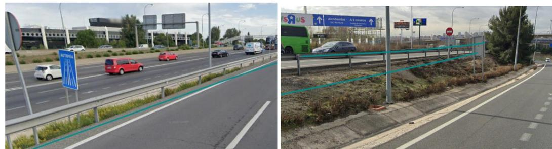
Fotografía 5. Pantalla PT-2. Barrera metálica existente. Vista anterior y posterior
