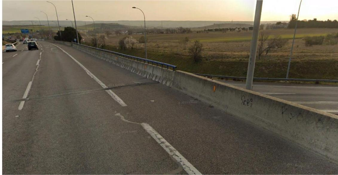
Fotografía 40. Sistemas de contención PT-17. Barrera de hormigón. Pretil mixto
