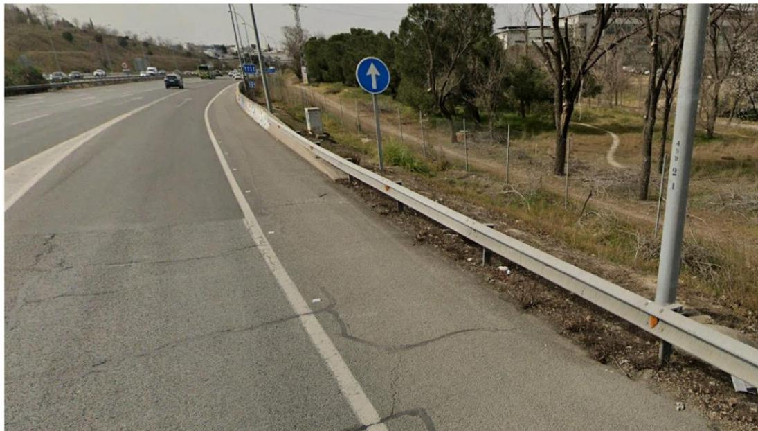
Fotografía 38. Sistemas de contención en PT-15. Barrera de hormigón en tronco. Barrera metálica en el ramal
