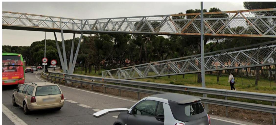
Fotografía 8. Pantalla PT-3 (PP\_A1\_13,2\_MD\_1\_3). Barrera metálica de doble altura y postes c/2m. Protección de pilas de paso superior peatonal
