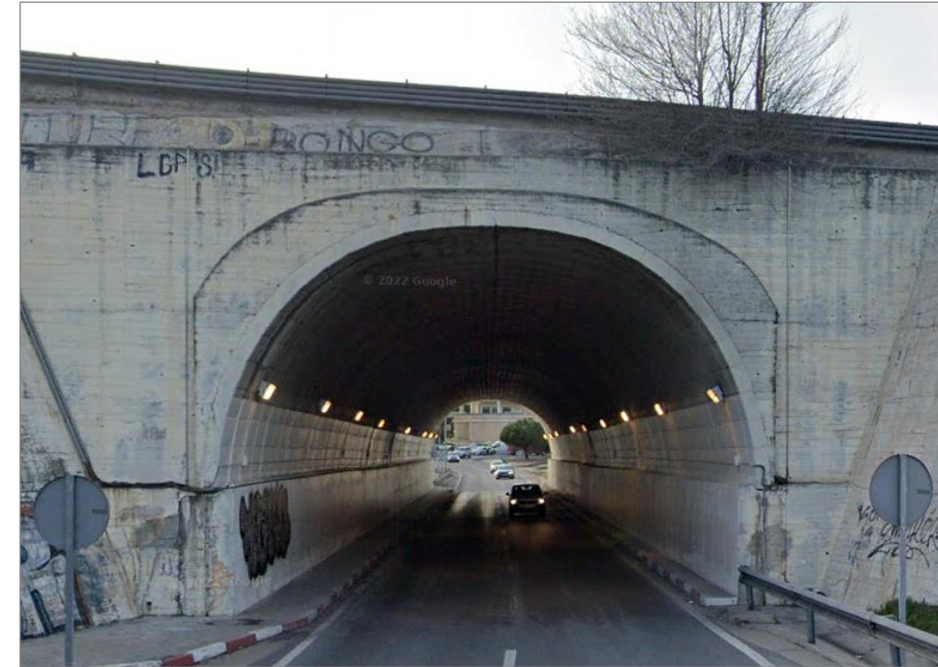
Fotografía 1. Bóveda existente sobre la que se sitúa la pantalla acústica.
