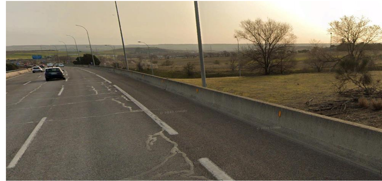
Fotografía 34. Entorno de la pantalla PT-17 Tramo PP_A1_16_MD_3_1. Isleta central glorieta
