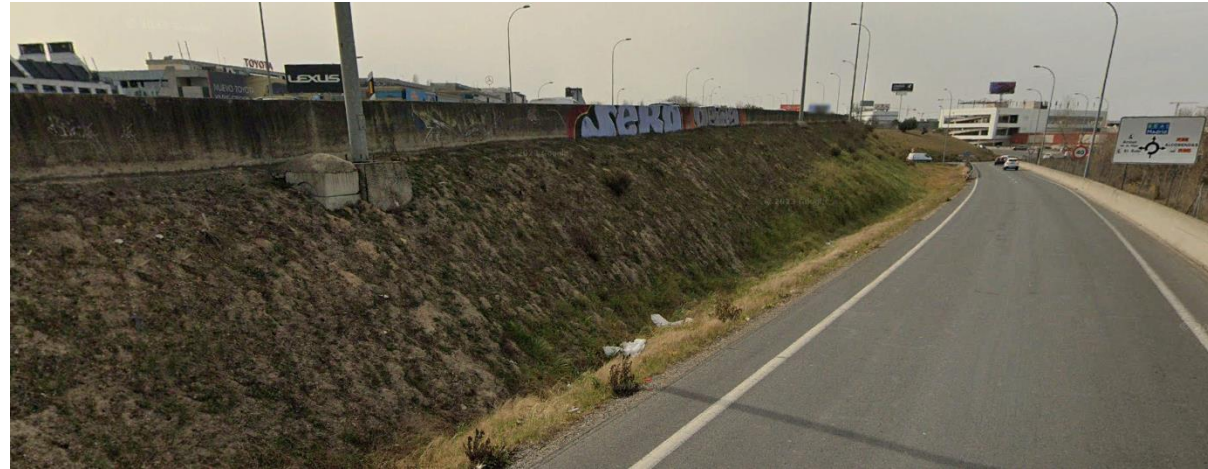
Fotografía 22. Entorno de la pantalla PT-11. Tramo PP_A1_16_MI_1_3 . Vista posterior
