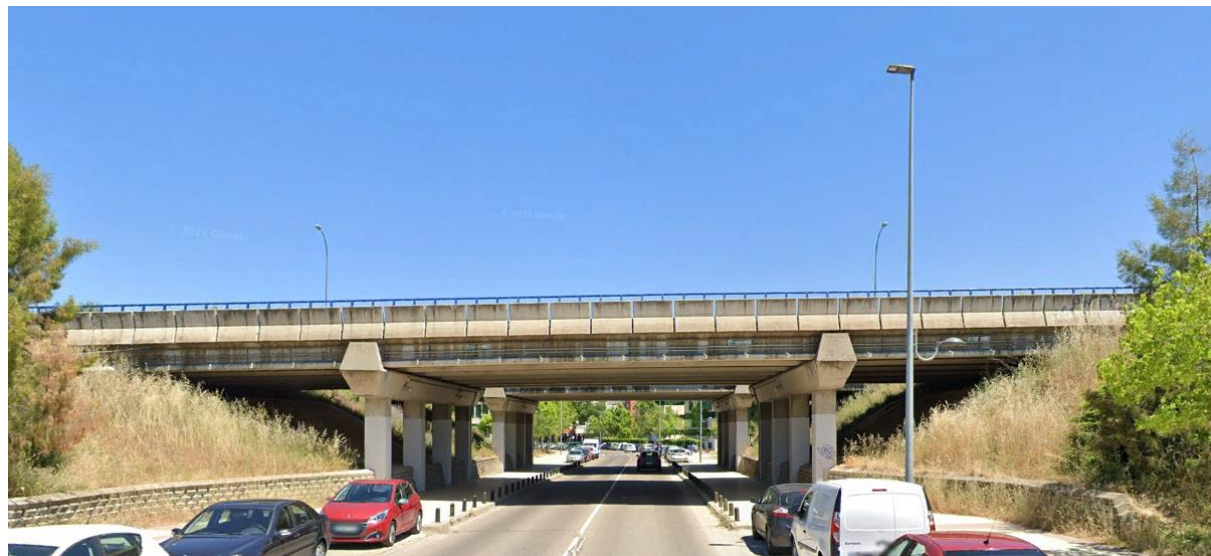
Fotografía 30. Entorno de la pantalla PT-13. Viaducto c/F. Delgado. (PP_A1_16_MD_1_5)
