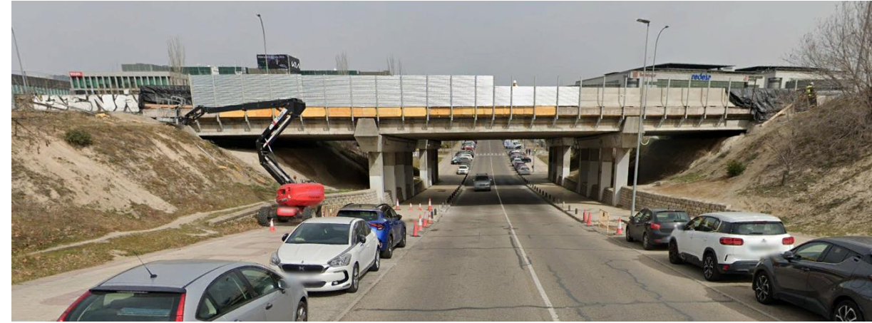
Fotografía 31. Entorno de la pantalla PT-13. Viaducto c/ A. Segura (PP_A1_16_MD_1_8)
