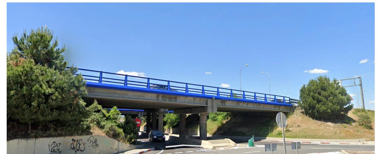
Fotografía 17. Entorno de pantalla PT-10. Tramo PP_A1_14,25_MD_2_3. Viaducto. Vista inferior
