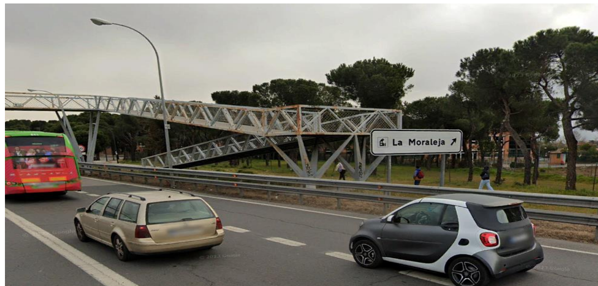
Fotografía 3. Entorno de la pantalla PT-3. Pasarela peatonal
