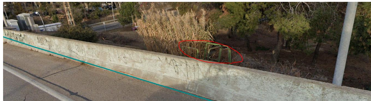
Fotografía 8. Entorno de la pantalla PT-5 -Tramo (PP_A1_14,25_MD_1_2). Condicionantes
