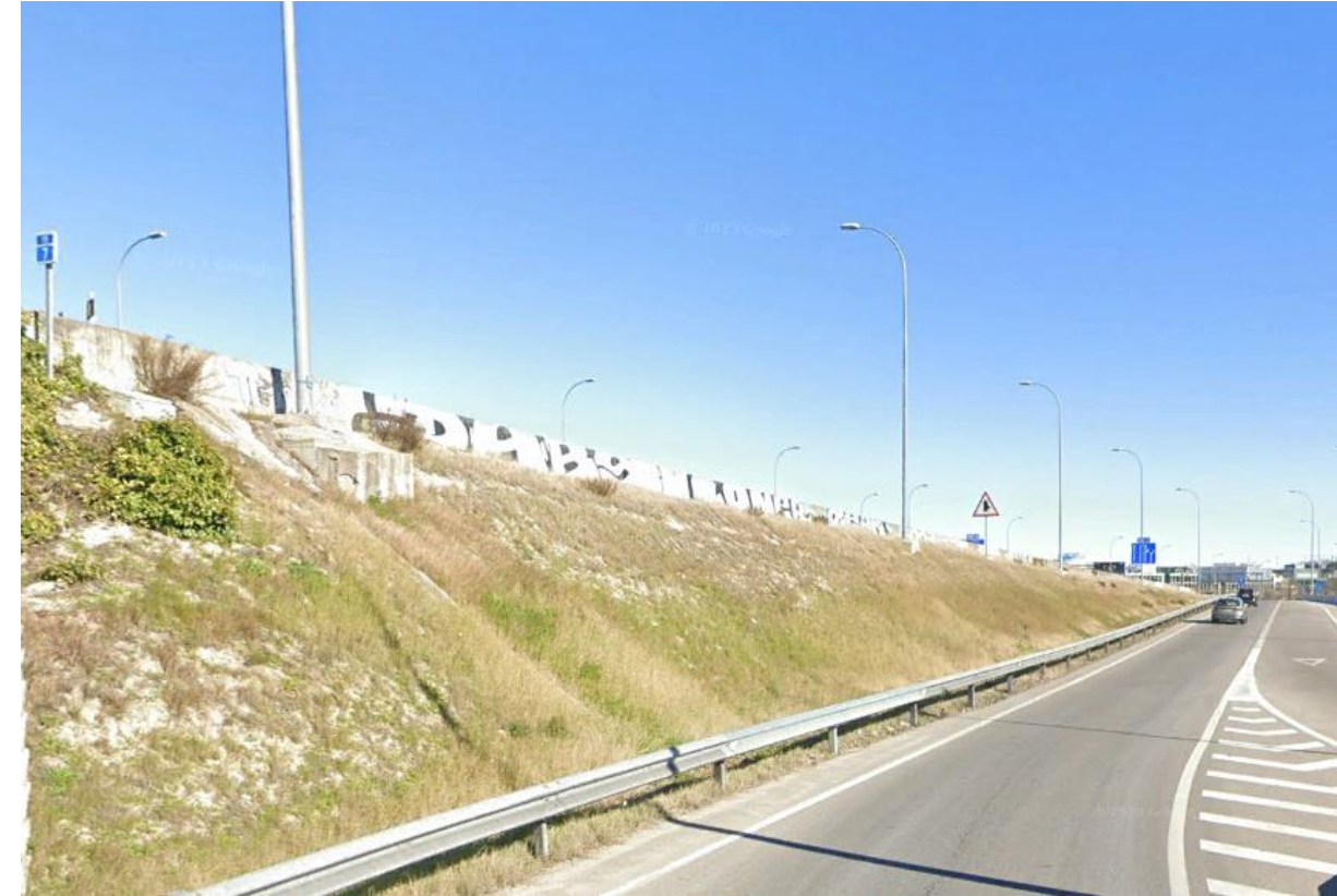
Fotografía 25. PT-12 (PP_A1_16_MD_1_1). Vista trasera de la barrera de hormigón
