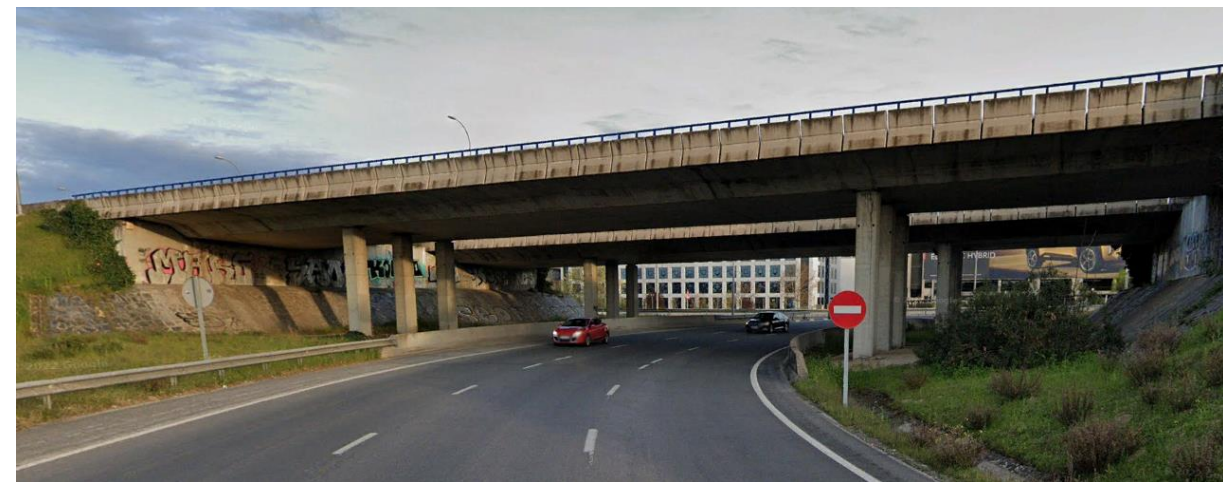
Fotografía 20. Entorno de la pantalla PT-11. Tramo PP_A1_16_MI_1_2. Viaducto. Vista inferior
