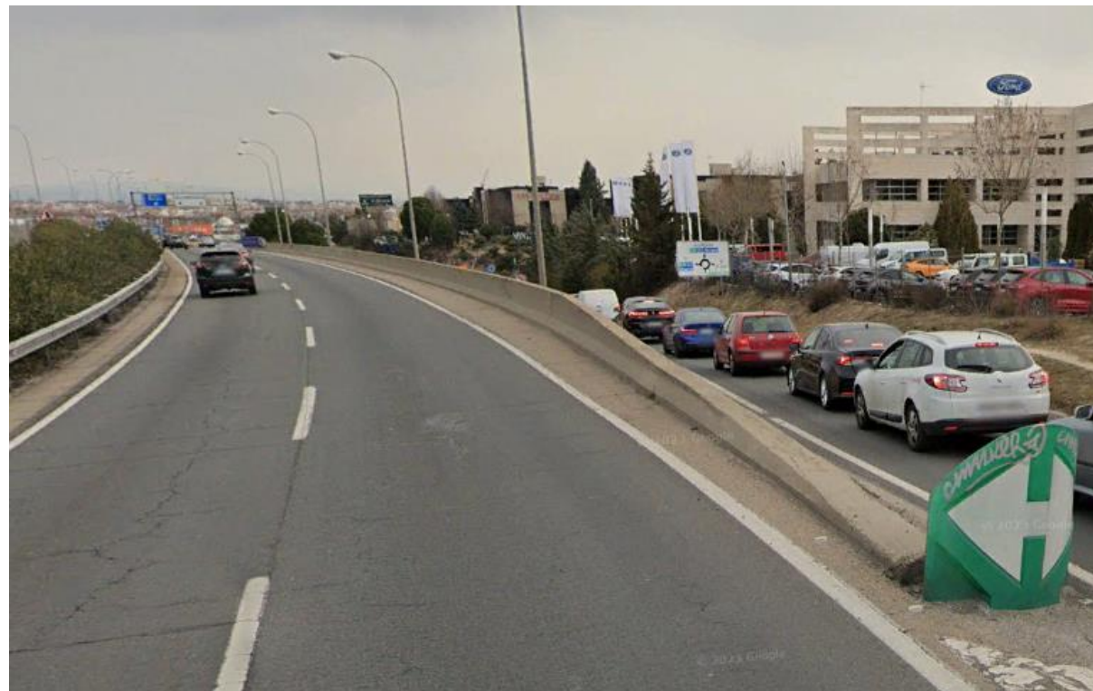
Fotografía 15. Entorno de pantalla PT-10. Tramo PP_A1_14,25_MD_2_2. Inicio
