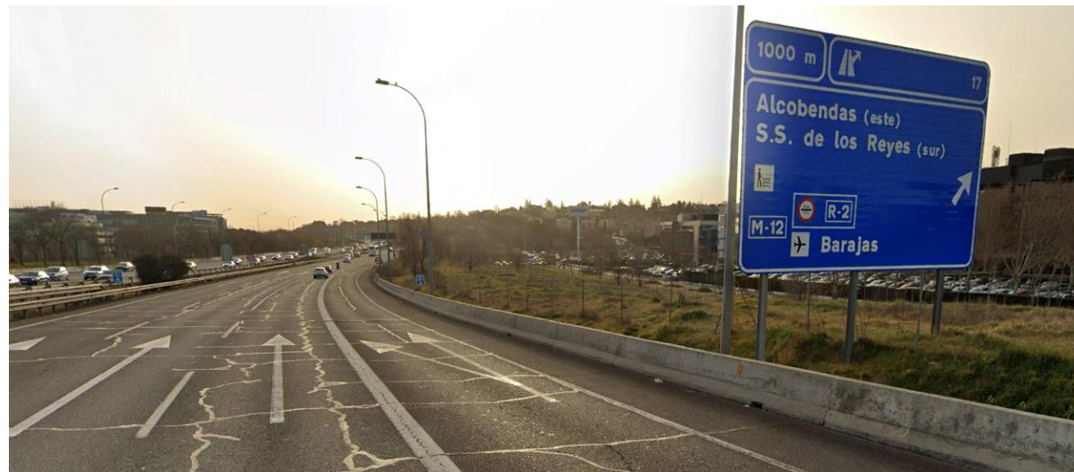
Fotografía 26. Entorno de la pantalla PT-13. Tramo PP_A1_16_MD_1_4
