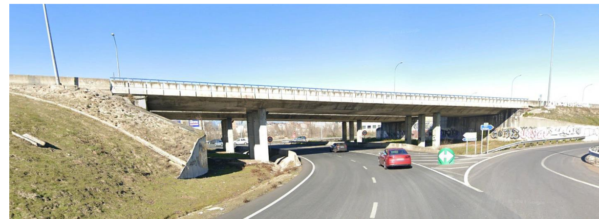
Fotografía 35. Pantalla PT-17. Vista inferior del viaducto. Glorieta. Tramo PP_A1_16_MD_3_2
