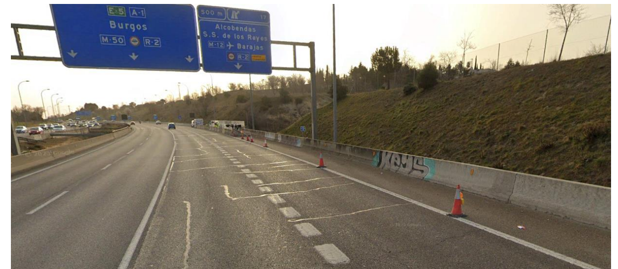
Fotografía 28. Entorno de la pantalla PT-13. Tramos PP_A1_16_MD_1_7, PP_A1_16_MD_1_8 y PP_A1_16_MD_1_9. Pantallas en cabeza de talud de desmonte
