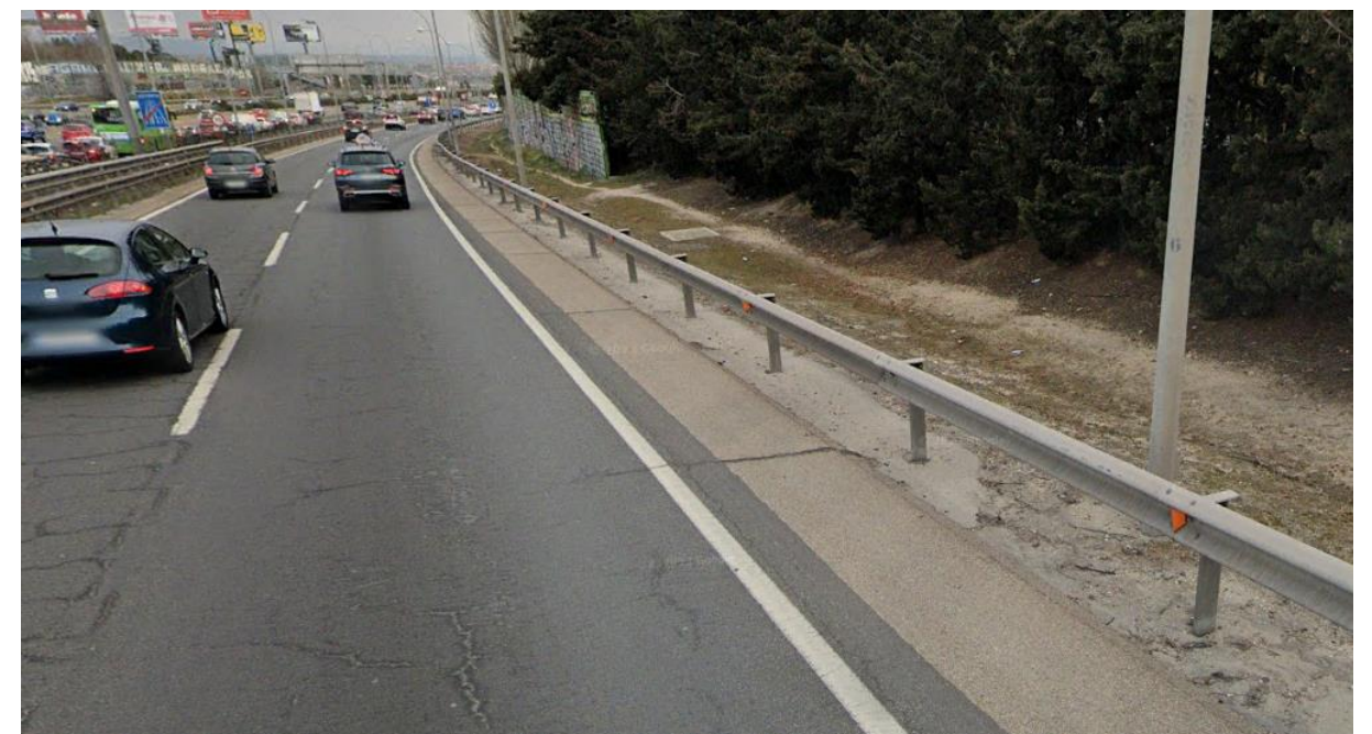
Fotografía 10. Entorno de la pantalla PT-5 -Tramo (PP_A1_14,25_MD_1_3). Conexión con pantalla existente
