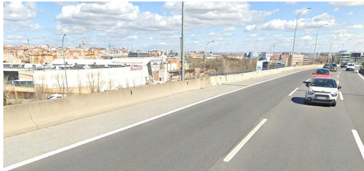
Fotografía 18. Entorno de la pantalla PT-11. Tramo PP_A1_16_MI_1_1. Inicio
