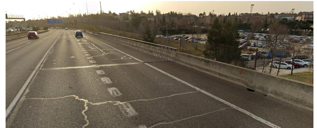
Fotografía 27. Entorno de la pantalla PT-13. Tramos PP_A1_16_MD_1_5 (viaducto) y PP_A1_16_MD_1_6
