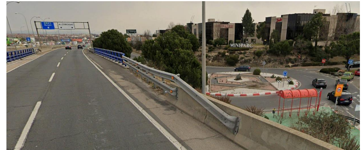
Fotografía 16. Entorno de la pantalla PT-10. Tramo PP_A1_14,25_MD_2_3. Viaducto
