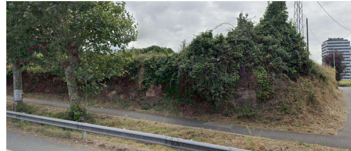
Vista del desmonte actual en el MD de la senda Eje173
