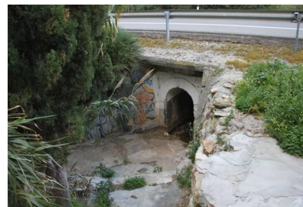
Obra de drenaje transversal en P.K. 75+830
