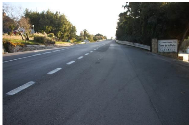
Tramo N-340 P.K. 77+910 con acceso directo a camping Torre de la Peña con giro a la izquierda (salida) permitido
