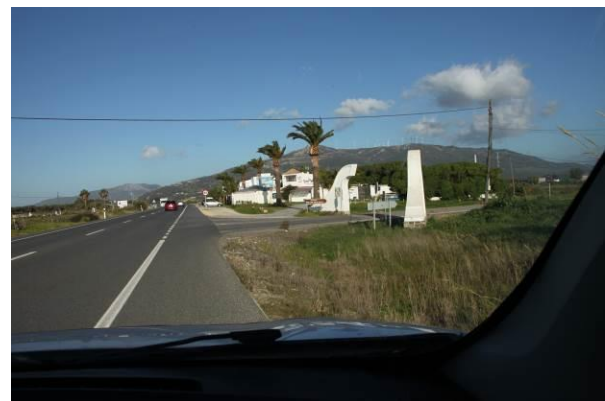
Ubicación prevista de glorieta nº6, en P.K. 81+400, en conexión con carretera Santuario Nuestra Señora de la Luz
