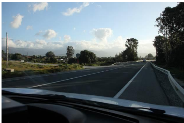
Tramo N-340 P.K. 78+300 con giro a la izquierda (incorporación) permitido
