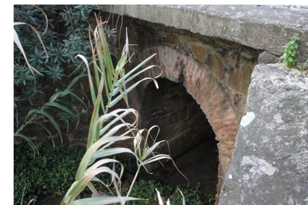
Obra de drenaje transversal en P.K. 77+005
