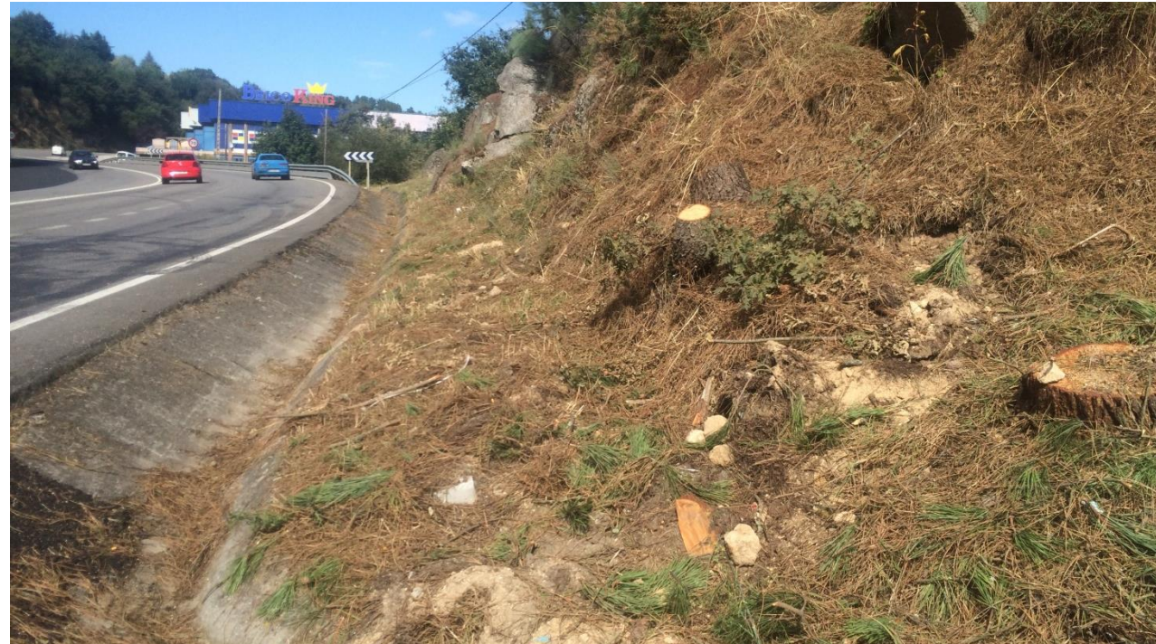
Imagen 1. Cuneta hormigonada en la margen derecha de la N-525.
