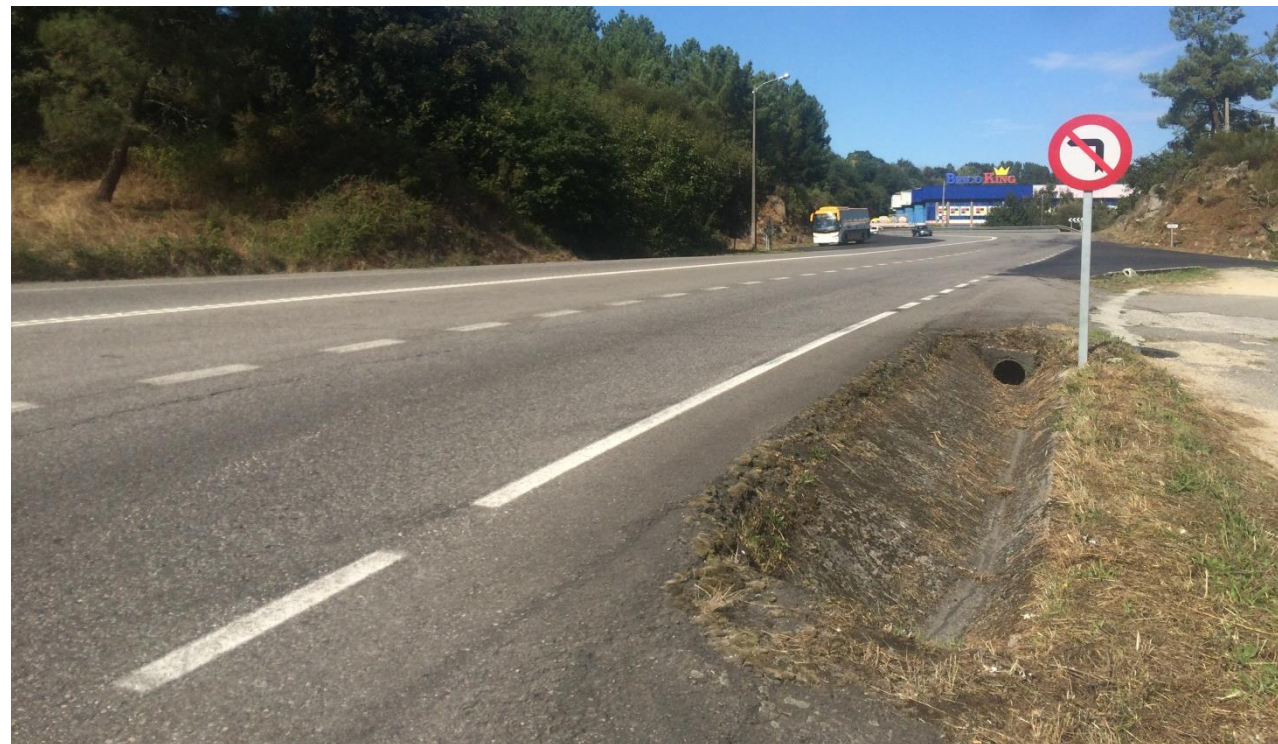
Imagen 2. Cuneta hormigonada y salvacunetas en accesos a propiedades colindantes.
