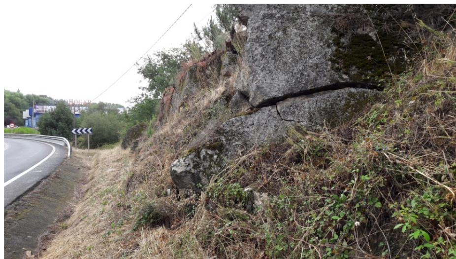
Foto 1. Afloramiento granítico afectado por fracturas PK 1+340
