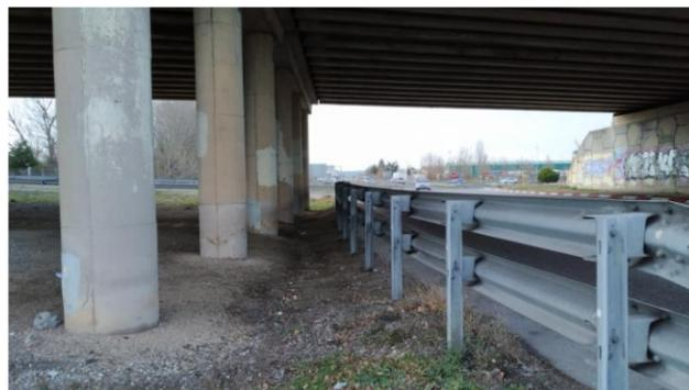
La separación entre las pilas de la estructura y el borde de calzada es de 1,90 m.
