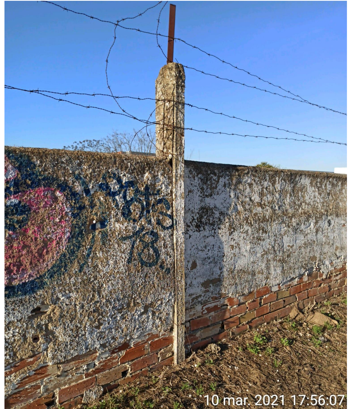
Ilustración 12. Muro de ladrillos de 2º con alambrada de 3º.
