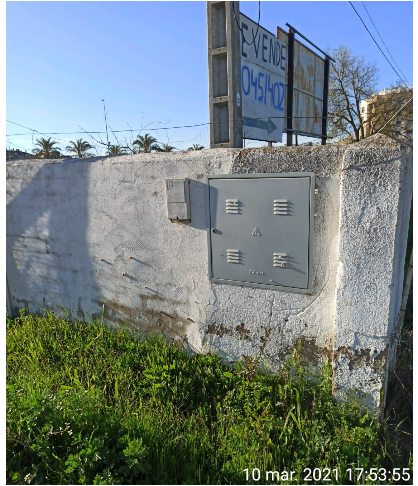
Ilustración 10. Muro de bloques de hormigón.
