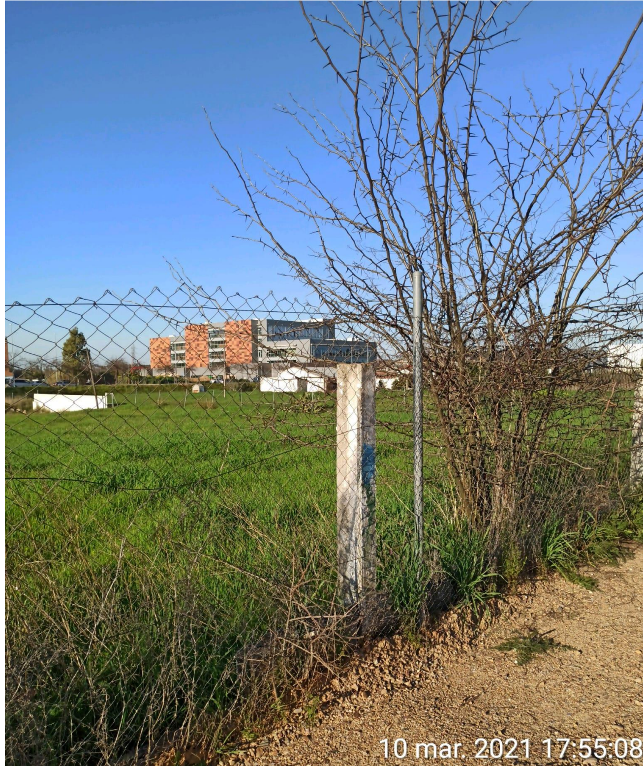
Ilustración 7. Malla de simple torsión de 1º con murete.
