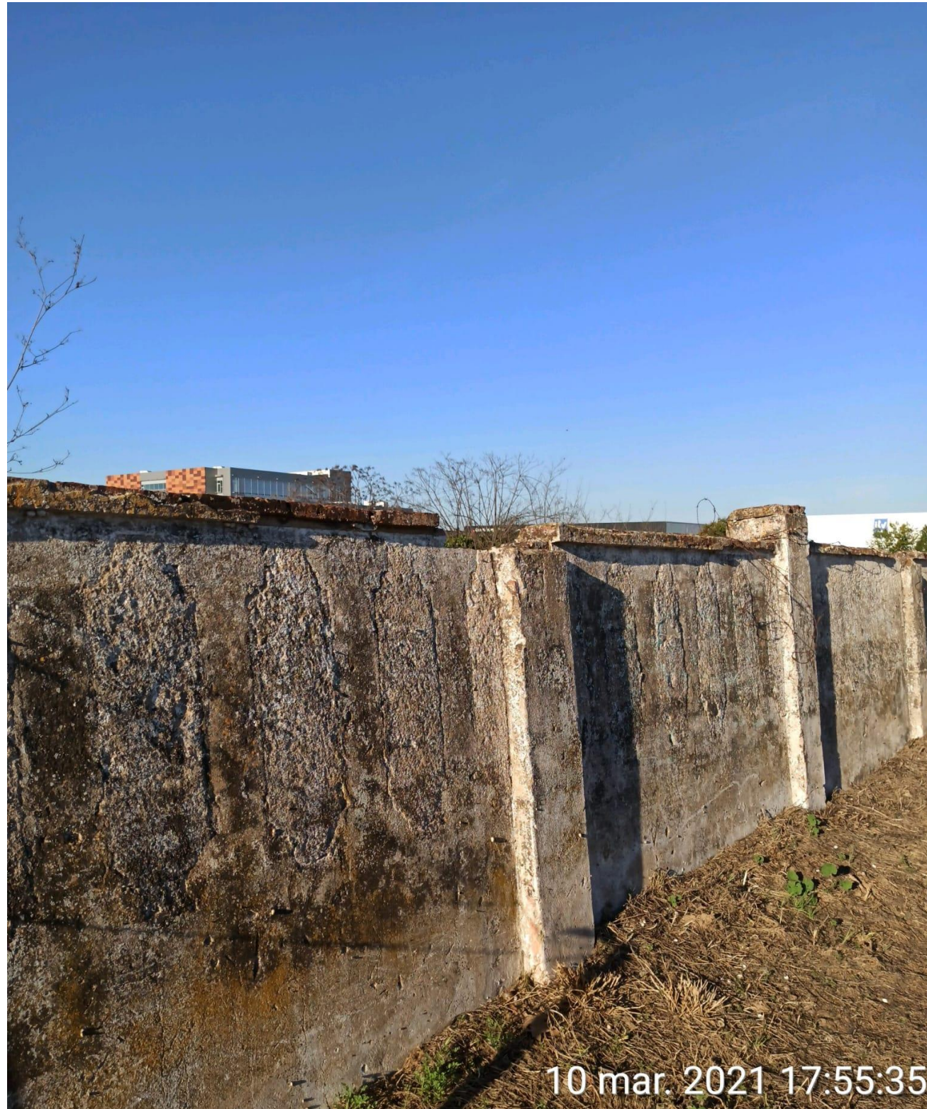
Ilustración 11. Muro de ladrillo de 1º.
