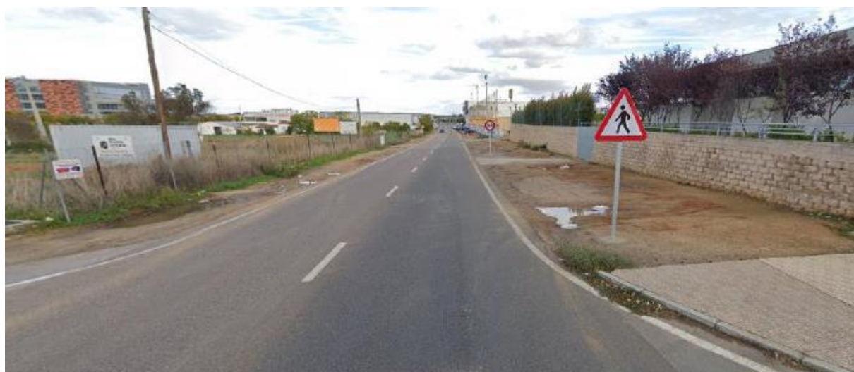
N-430 (PK 1+240). Inicio tramo actuación
