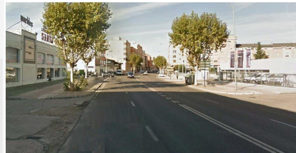
Final tramo duplicado N-430 (PK 1+240)
