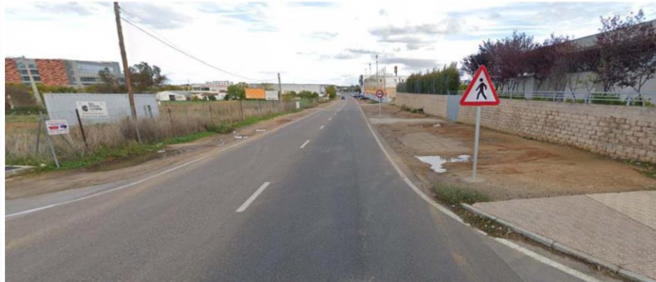
N-430 (PK 1+240). Inicio tramo actuación
