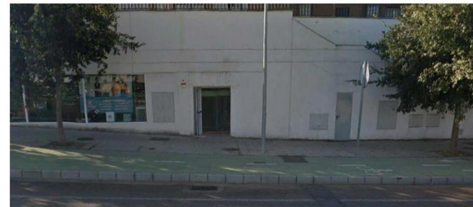
Acerados y carril bici (Parcela comercial)
