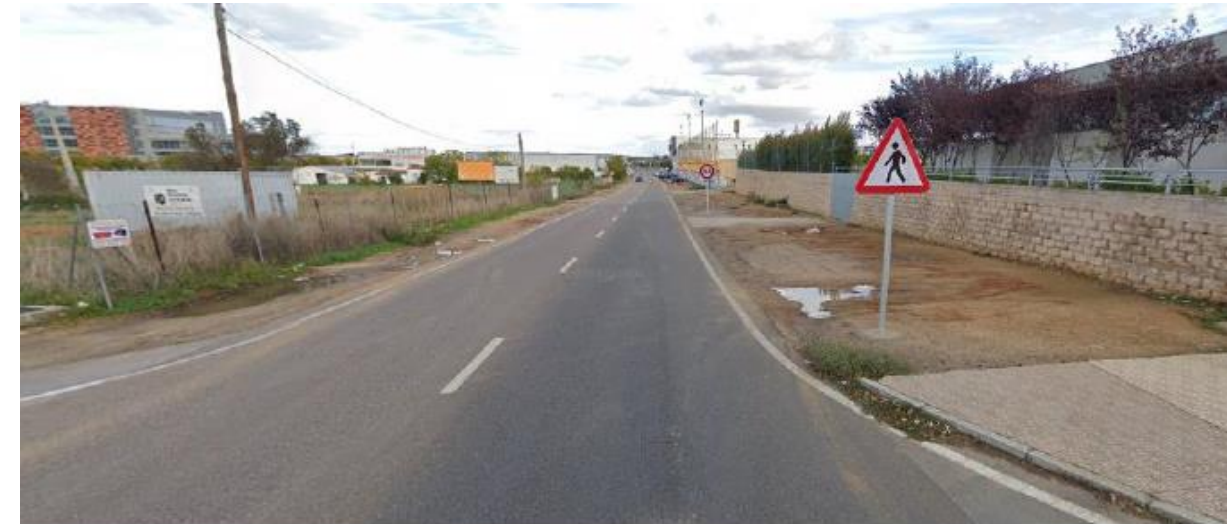
N-430 (PK 1+240). Inicio tramo actuación
