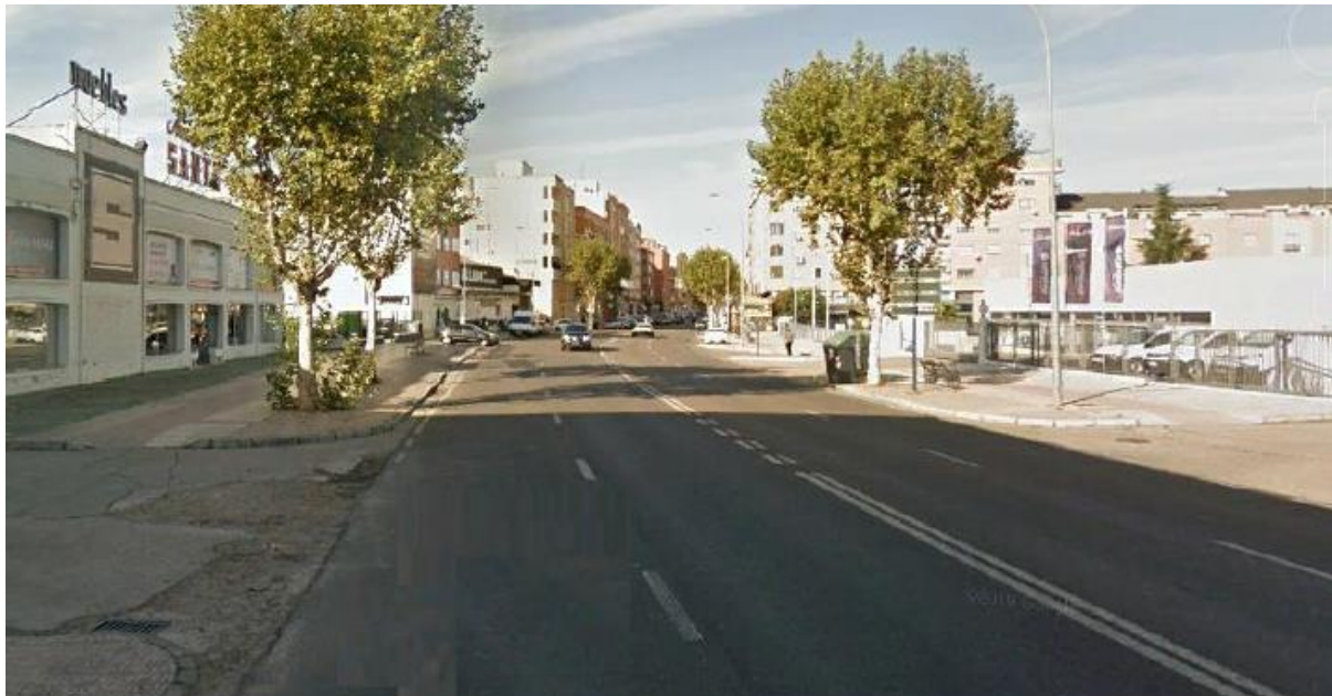
Final tramo duplicado N-430 (PK 1+240)
