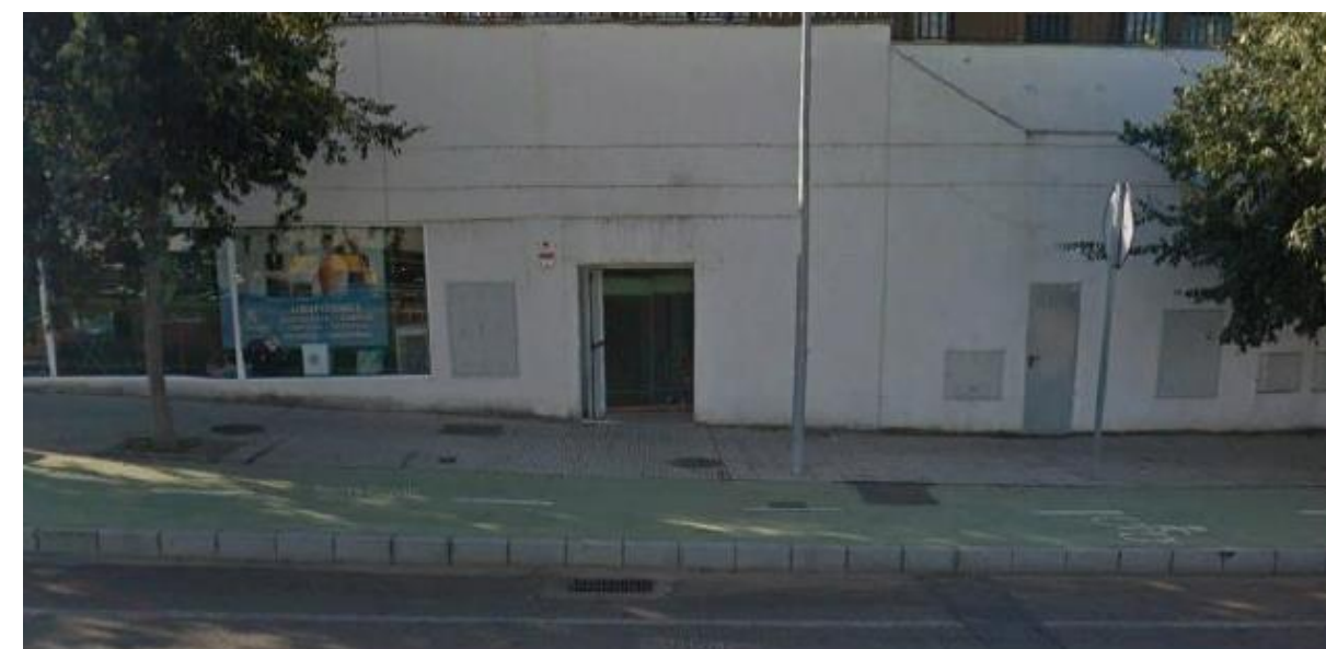
Acerados y carril bici (Parcela comercial)
