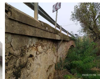
Punto en el que la viga se apoya en ménsula Vuelo irregular de aproximadamente 20 cm en la mayor parte del puente
