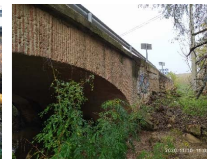
Puente aguas arriba
