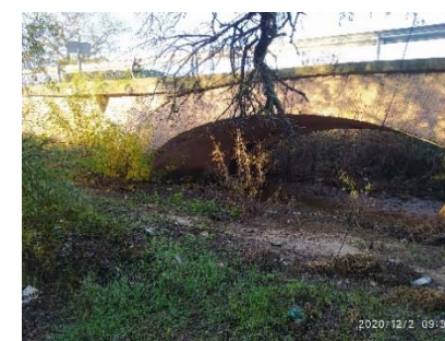
Puente aguas arriba
