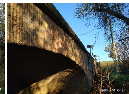
Punto en el que la viga se apoya en ménsula Vuelo irregular de aproximadamente 20 cm en la mayor parte del puente
