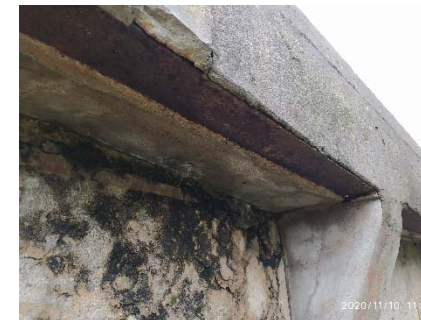
Punto en el que la viga se apoya en ménsula Vuelo irregular de aproximadamente 20 cm en la mayor parte del puente
