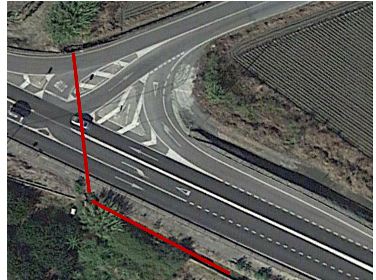
Paso de agua existente y canal en el borde carretera margen derecha
