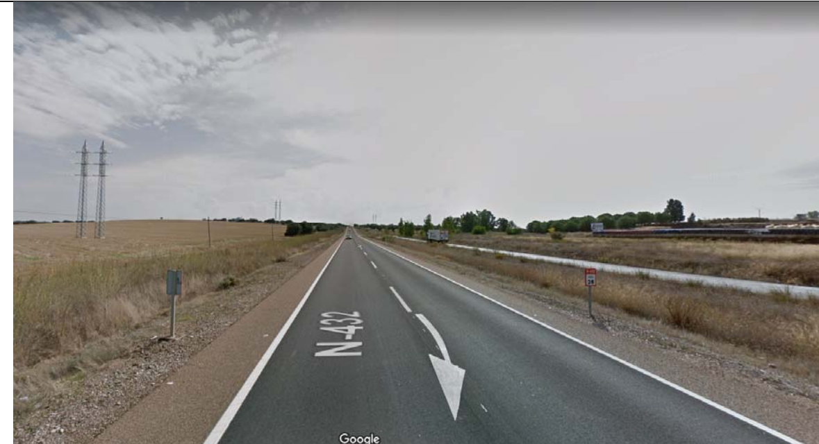
P.K. 26+000 sentido Córdoba. Bermas de aproximadamente 50 cm y cunetas de 2,0 m de ancho y 0,50 m de profundidad en M.I.
