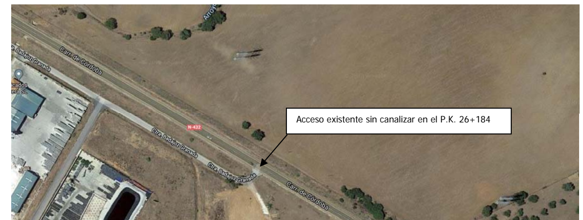
Ortofoto del acceso sin canalizar
