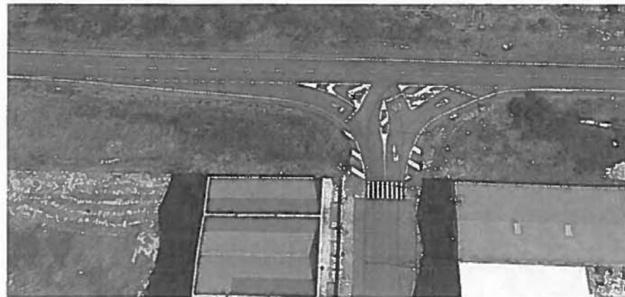
Acceso inicial a Polígono
