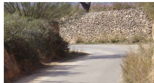
7_INTERSECCIÓN DE CAMINO DE DARMOS CON CAMINO DE ACCESO A PASO A NIVEL
