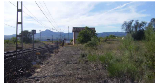
5_VISTA DE PARCELAS ALEDAÑAS A PASO A NIVEL
