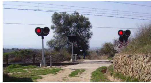
1_VISTA PASO A NIVEL 532/738 DESDE MARGEN IZQUIERDA
