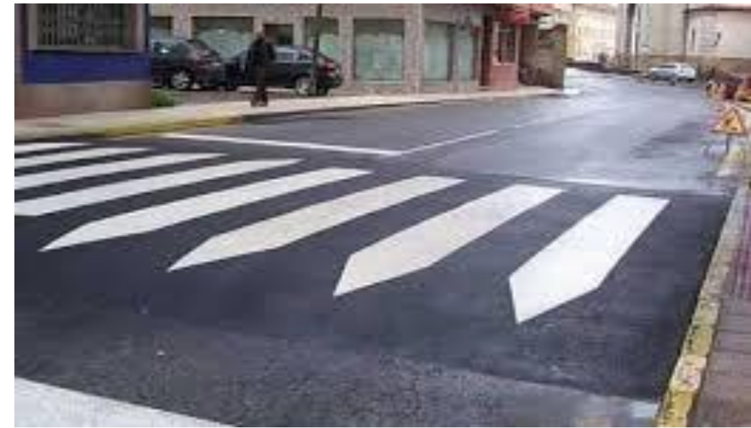
Ilustración 4. Imagen de paso de peatones elevado para reducción de velocidad
