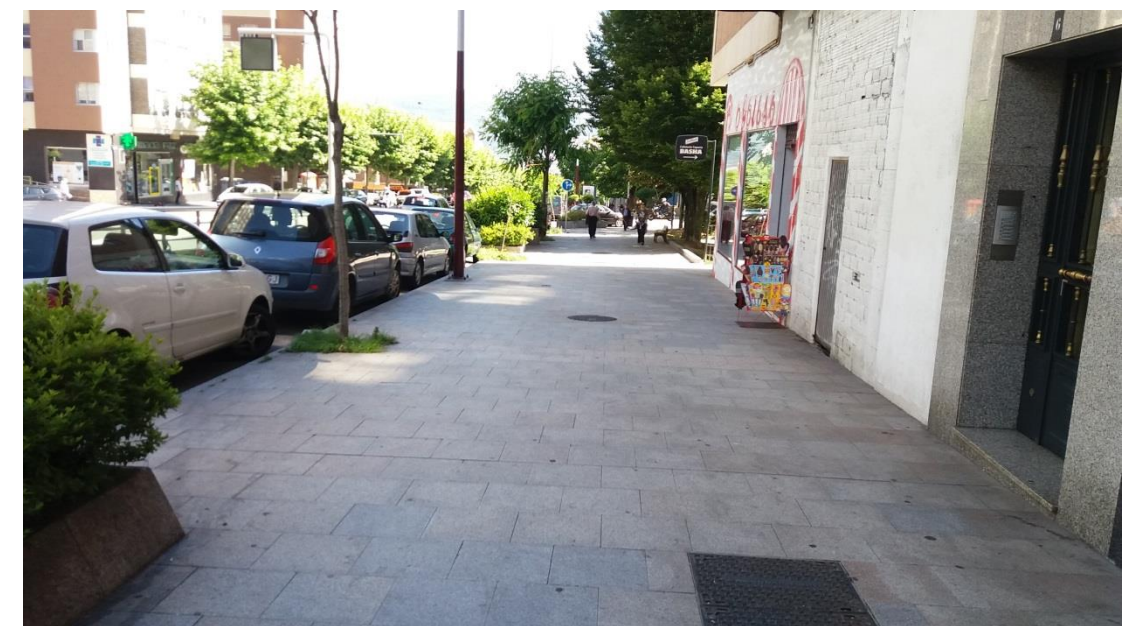
Ilustración 1. Aceras con pavimento de baldosa de granito Gris Mondariz
