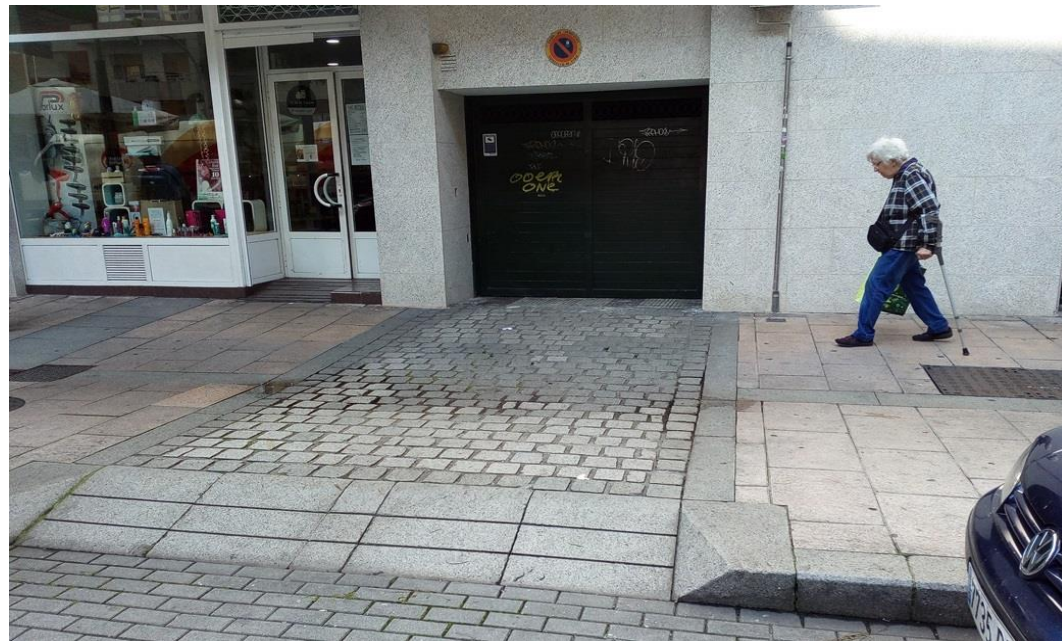
Ilustración 3. Vista de pavimentación en acceso a aparcamiento o garajes
