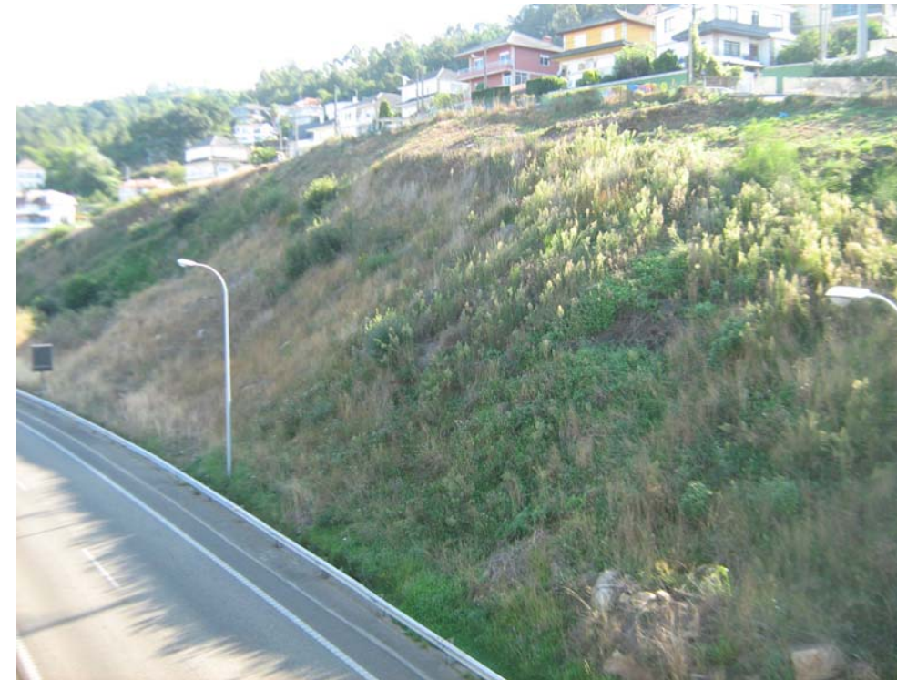
La estructura se desarrolla sobre el suelo de alteración tipo Jabre.
