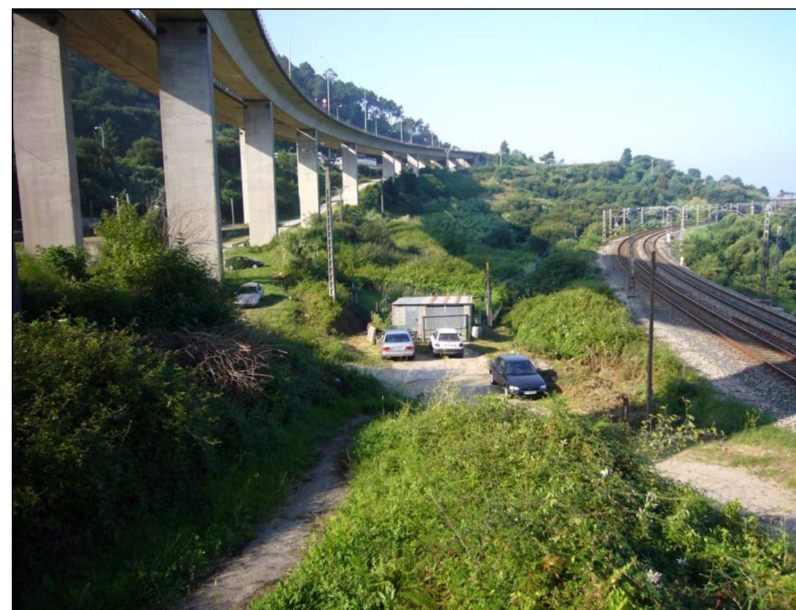
Zona con depósitos de jabre a lo largo del viaducto sur.
