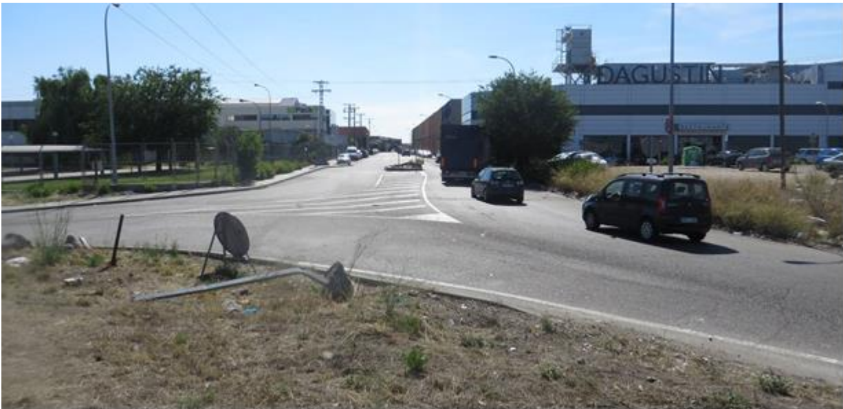
Acceso actual al polígono. Fuente TYPSA
