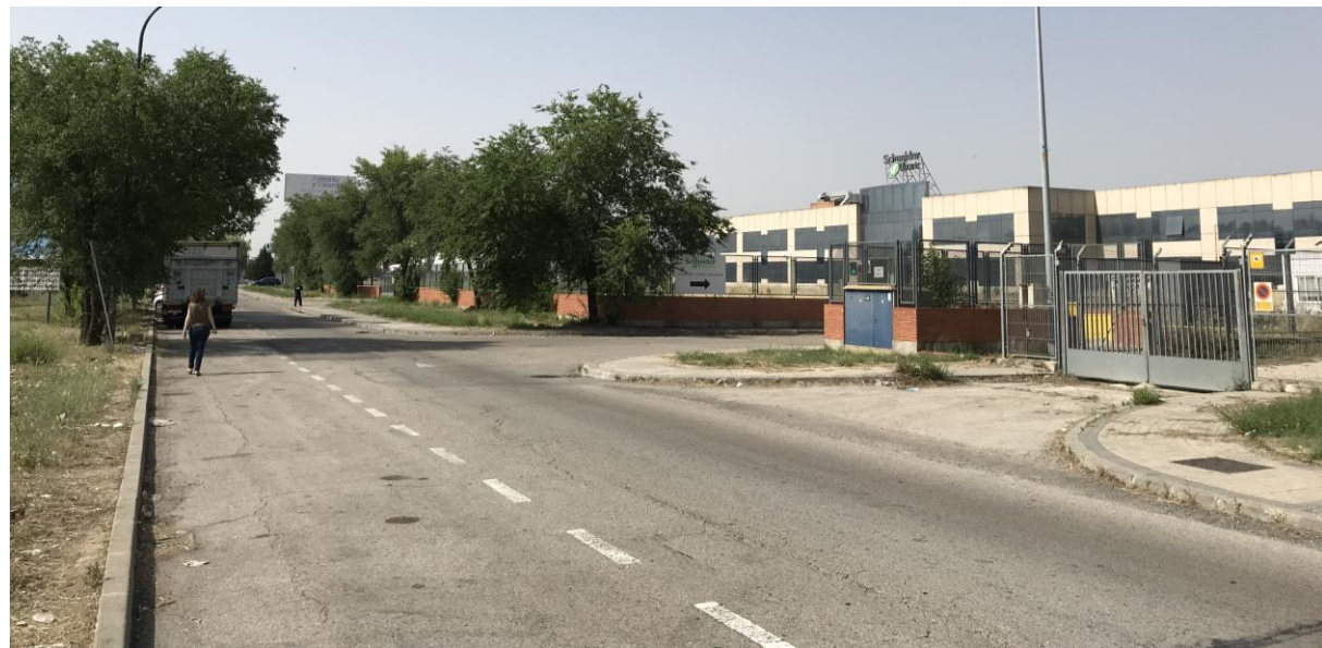
Acceso a una de las fincas del polígono. Fuente TYPESA
