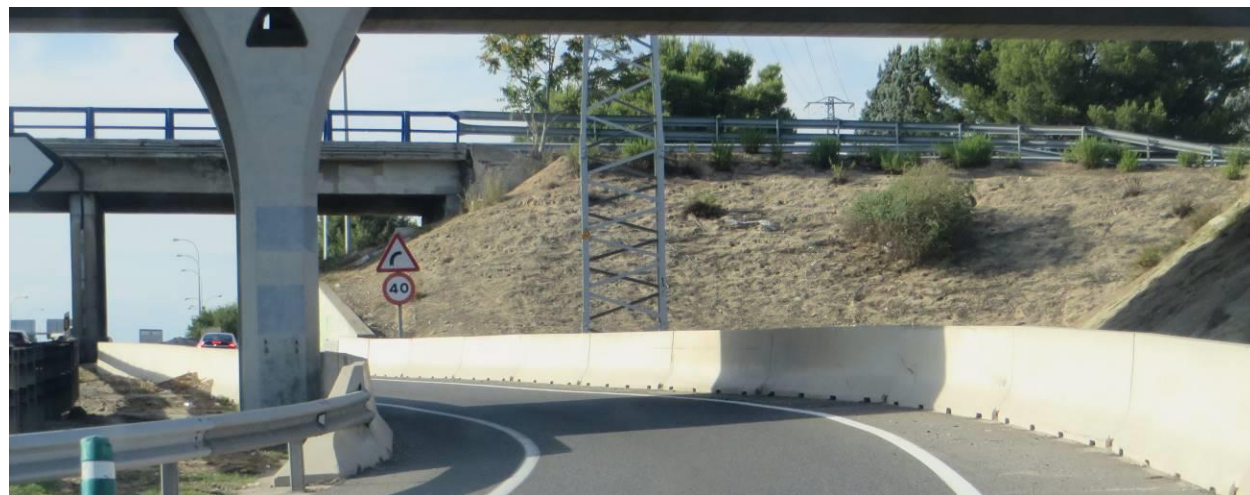
Vía lateral existente Fuente TYP SA
