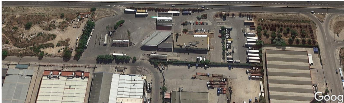
Gasolinera existente margen derecha. Fuente Google Earth
