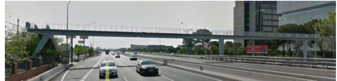
Figura: Vista general pasarela nº1 existente
