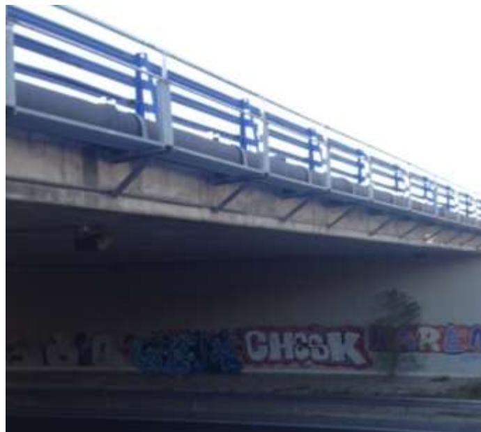
Imagen: Vista PS existente desde lado norte.
