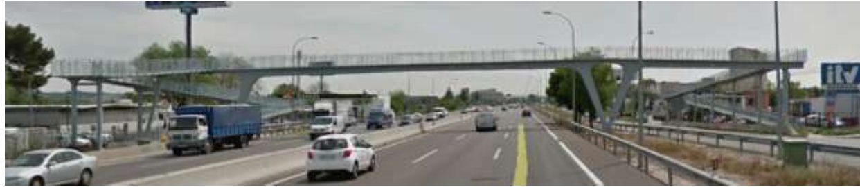
Figura: Vista general pasarela nº3 existente
