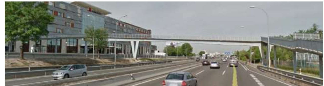
Figura: Vista general pasarela nº2 existente
