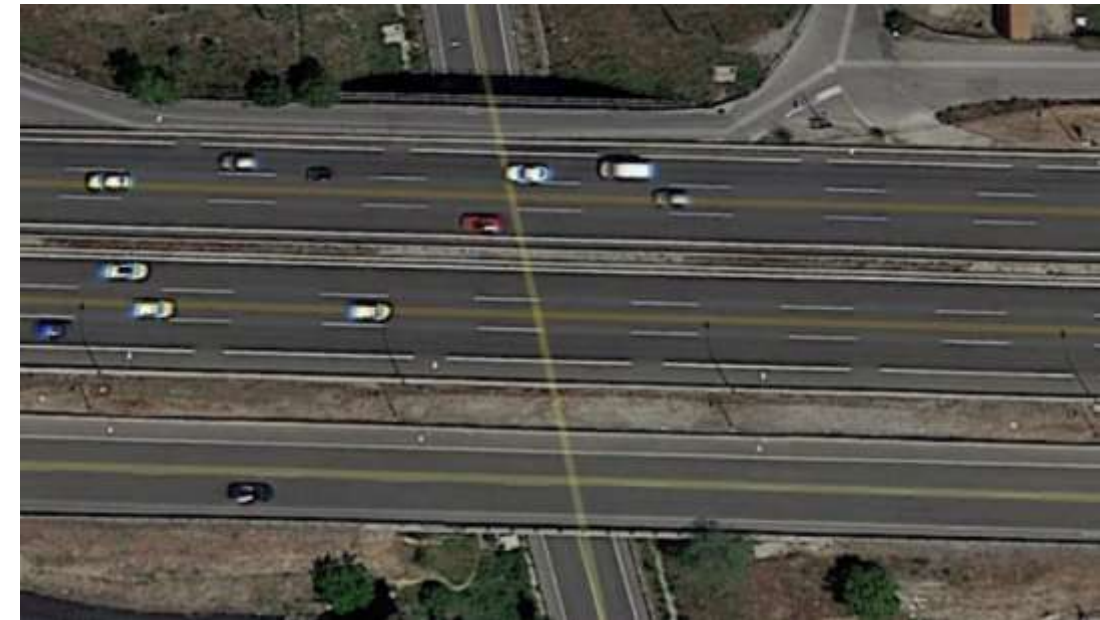
Imagen: Vista aérea del PS existente.
