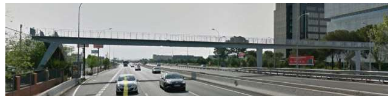
Figura: Vista general pasarela n° 1 existente
