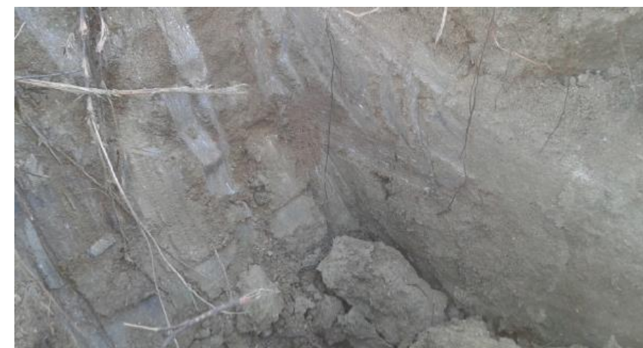
Aspecto de los materiales de la unidad T2 en la calicata C6.
