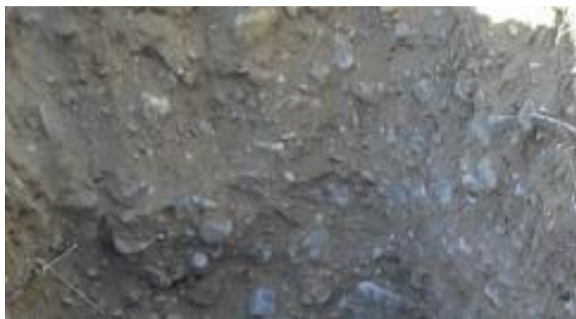
Aspecto de los materiales de la unidad QT en la calicata C2.
