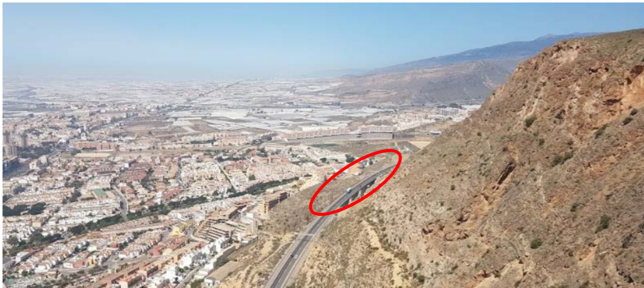
Ilustración 100: Ubicación de la autovía y Viaducto de Aguadulce en relación con el mirador Fuente: Google maps
