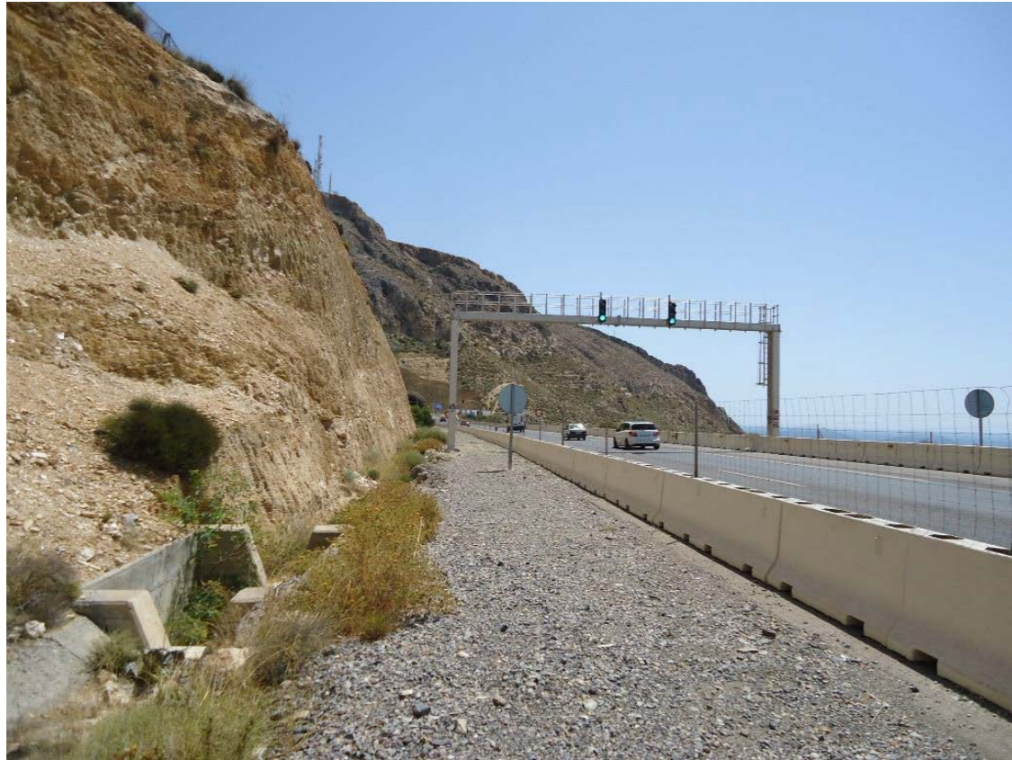
Ilustración 2: Berma en la calzada sur a acondicionar como camino de obra y acceso. Fuente: Elaboración propia
