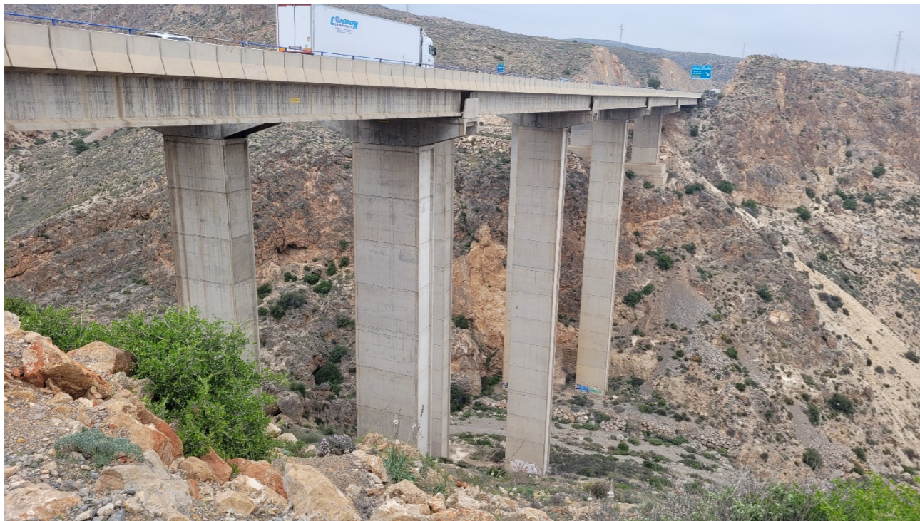
Ilustración 26: Panorámica pares de pilas 2,3,4 y 5 del viaducto de La Garrofa. Fuente: Elaboración propia
