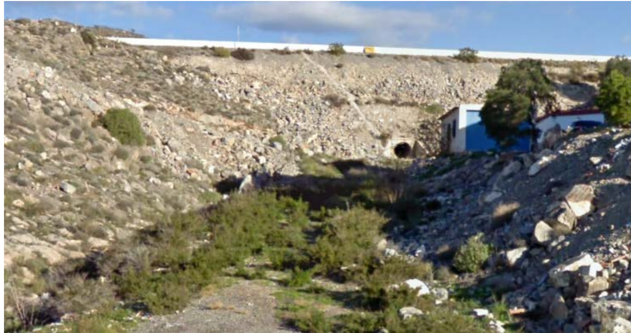
Ilustración 97: Zona de terraplén entre P.K. 437+100-438+300. Fuente: Elaboración propia
