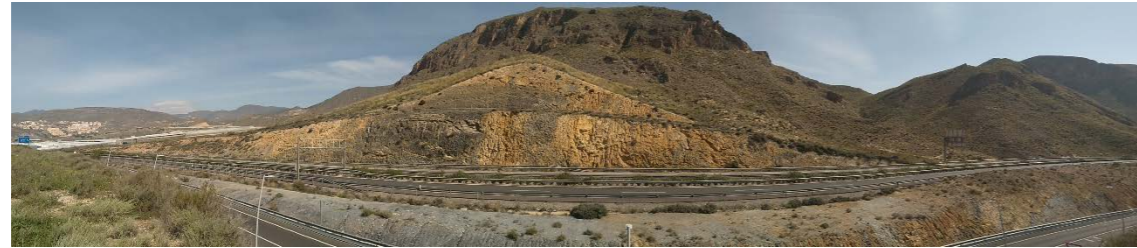
Ilustración 106: Panorámica del desmonte del P.K. 430+200 . Fuente: Elaboración propia
