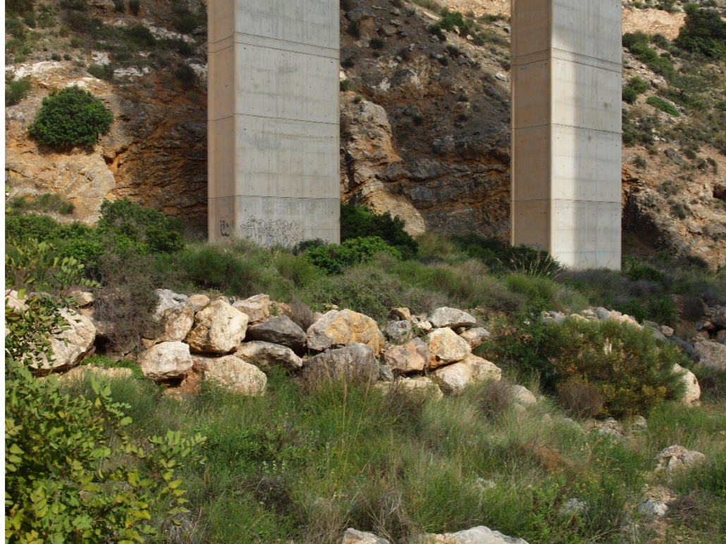
Ilustración 25: Panorámica pares de pilas 4 del viaducto de El Palmer. Fuente: Elaboración propia
