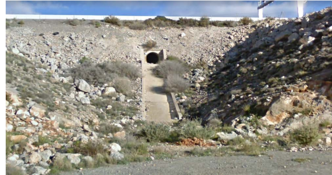
Ilustración 96: Zona de terraplén entre P.K. 437+100-438+300. Alt. 1. Fuente: Elaboración propia
