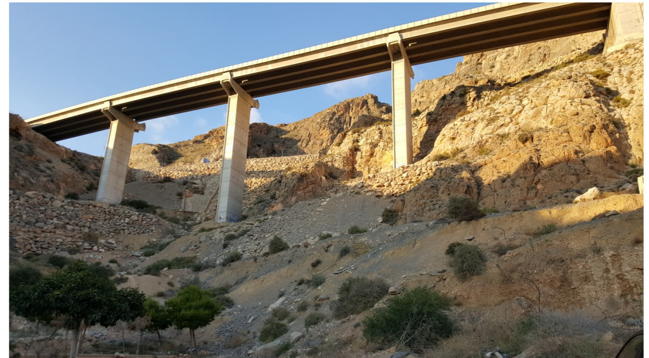
Ilustración 23: Panorámica pares de pilas 1, 2 y 3 del viaducto de Aguadulce. Fuente: Elaboración propia
