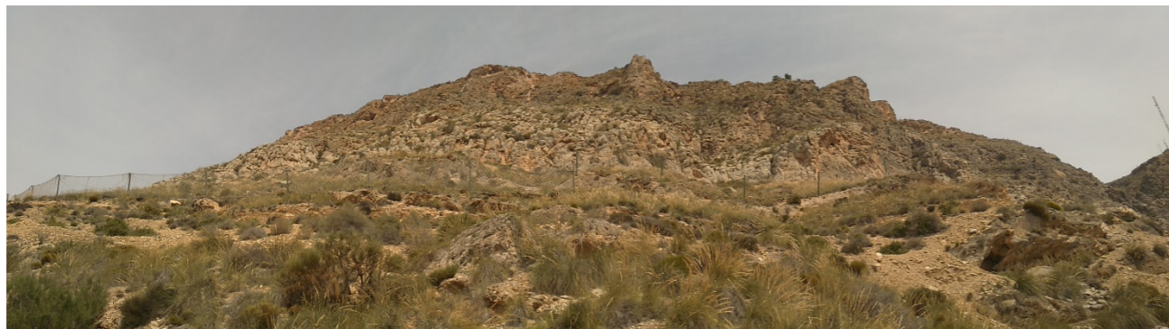
Ilustración 107: Desmonte en margen derecha, en la zona del camino de acceso a la galería . Fuente: Elaboración propia
