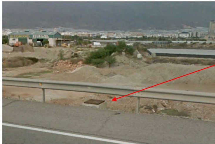
Arqueta cable troncal de 24 F.O. en ramal de incorporación, dirección Málaga
