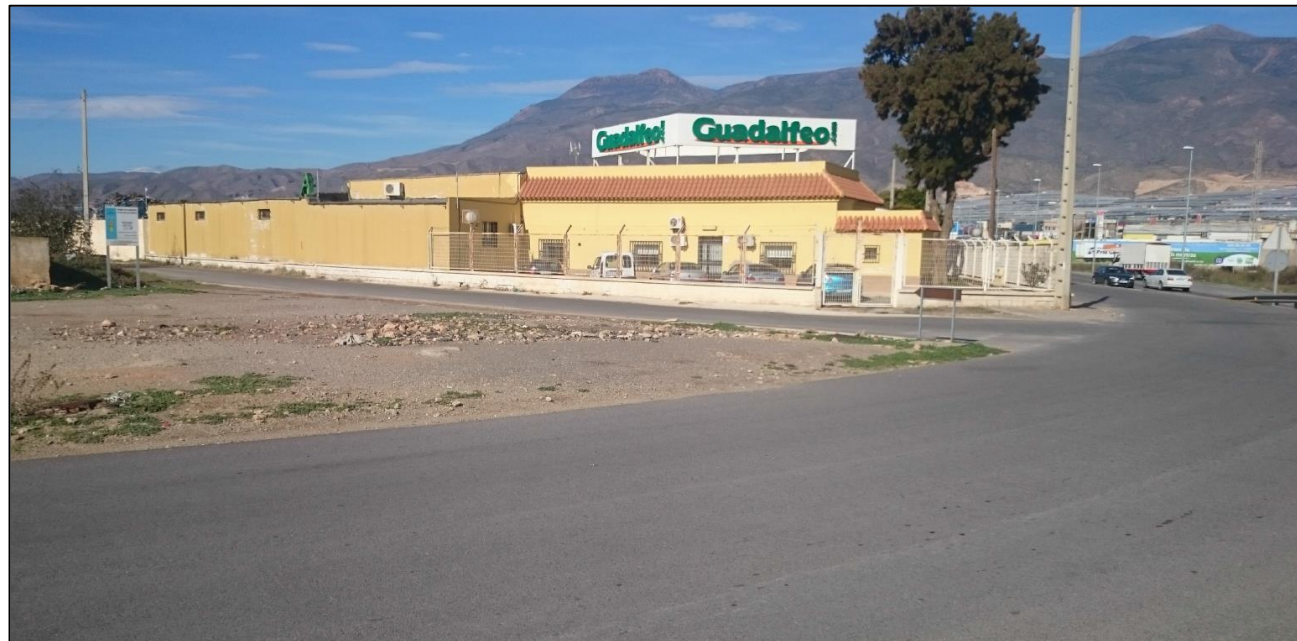
Camino Noroeste. Conexión con vía de servicio
