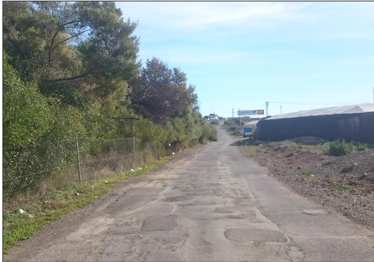
Camino Suroeste. Tramo asfaltado
