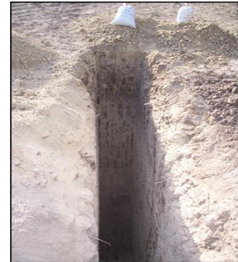
Excavación de la calicata.
