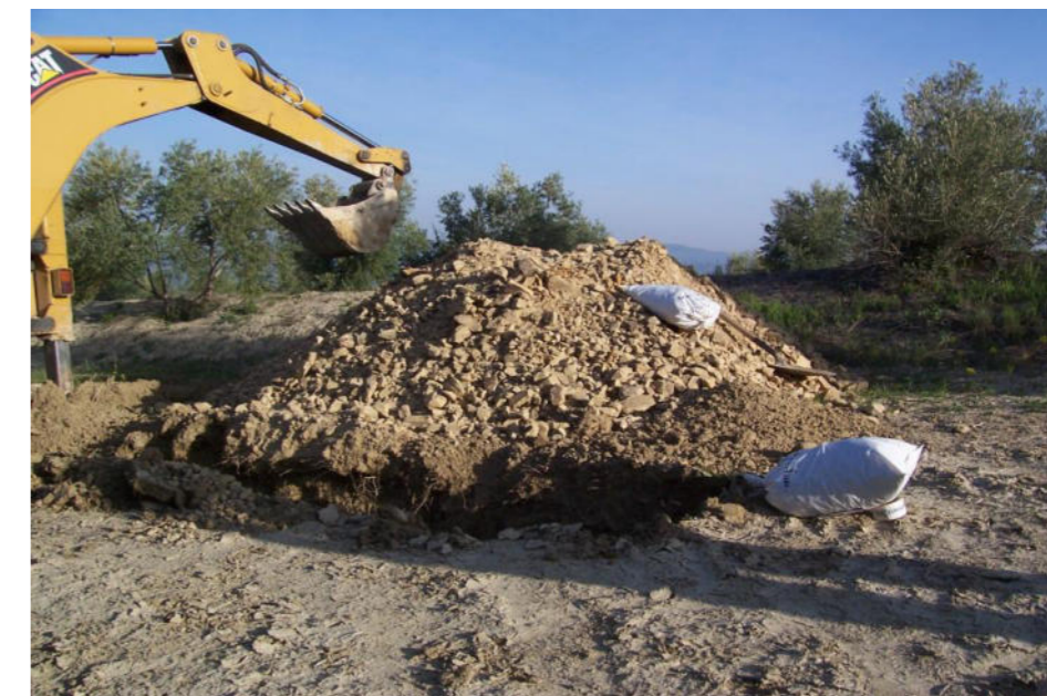
Materiales extraídos en la calicata.
