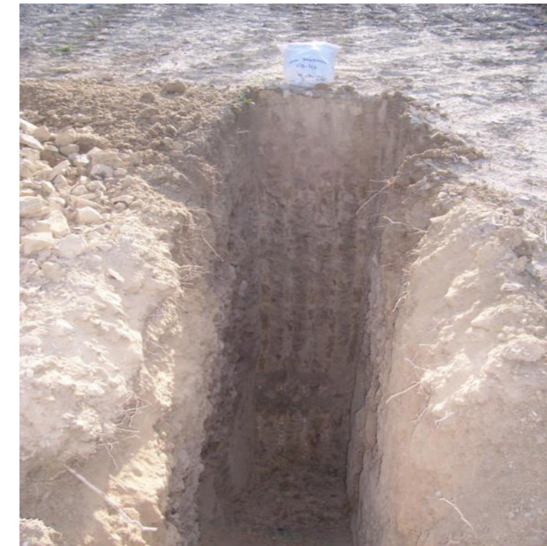
Excavación de la calicata.
