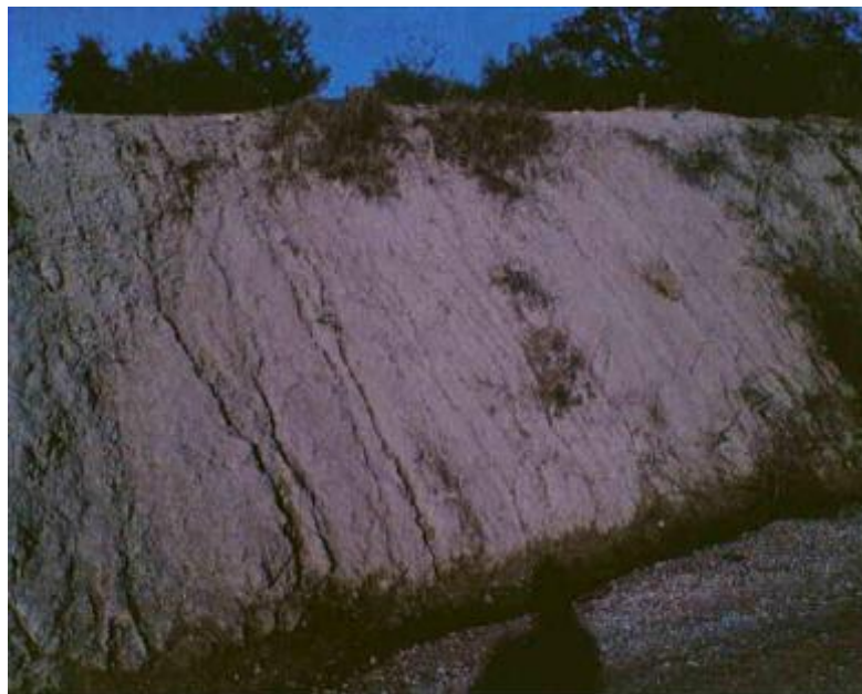
Foto 4. Talud en margas marones claras grisáceas (M M )
