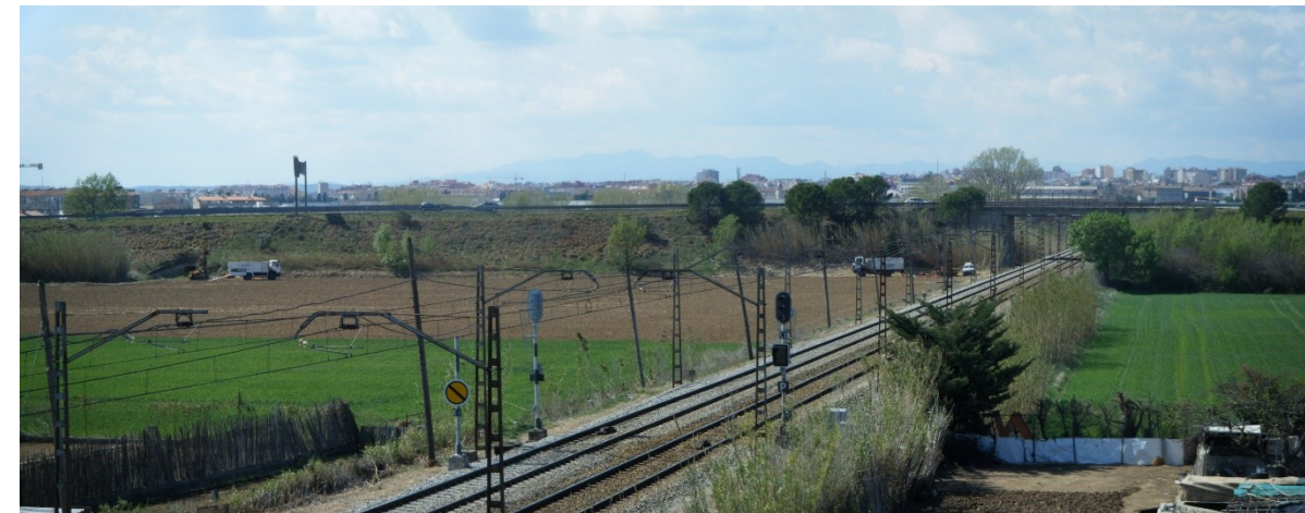
Figura 1. Panorámica de la N-II a en el cruce (P.I.) con el FFCC Barcelona – Figueres – Portbou. Obsérvese a las máquinas sondeando el subsuelo al pie del relleno actual de la carretera.
