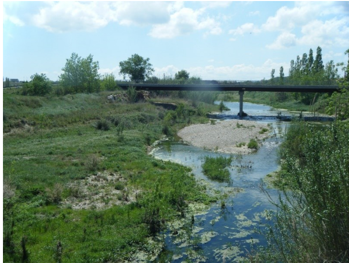
Figura 6. Terrazas actuales y lecho del río Manol
