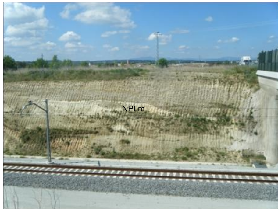
Figura 3. Afloramiento de la unidad NPLm en el talud ferroviario.
