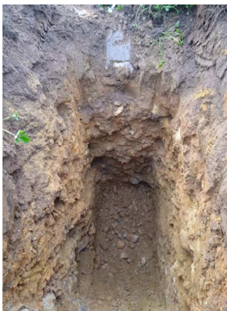
Detalle aluvial grueso en la calicata C-1
